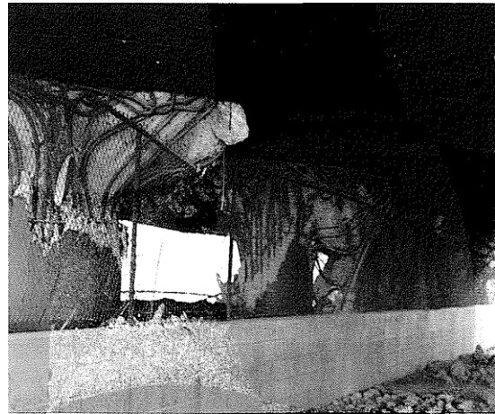
Endommagement du poteau dû à une rupture par cisaillement séisme de San Fernando-California 1971
