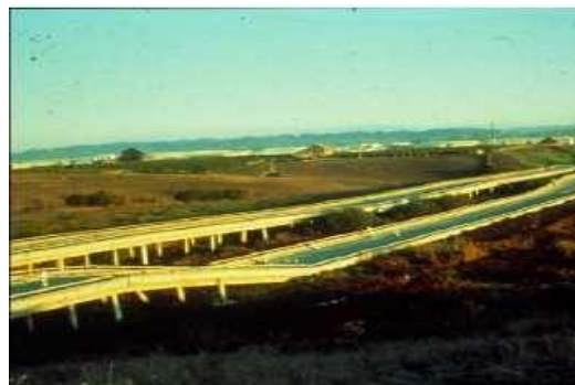
Séisme de Loma Prieta–San Francisco 1989 [26]
