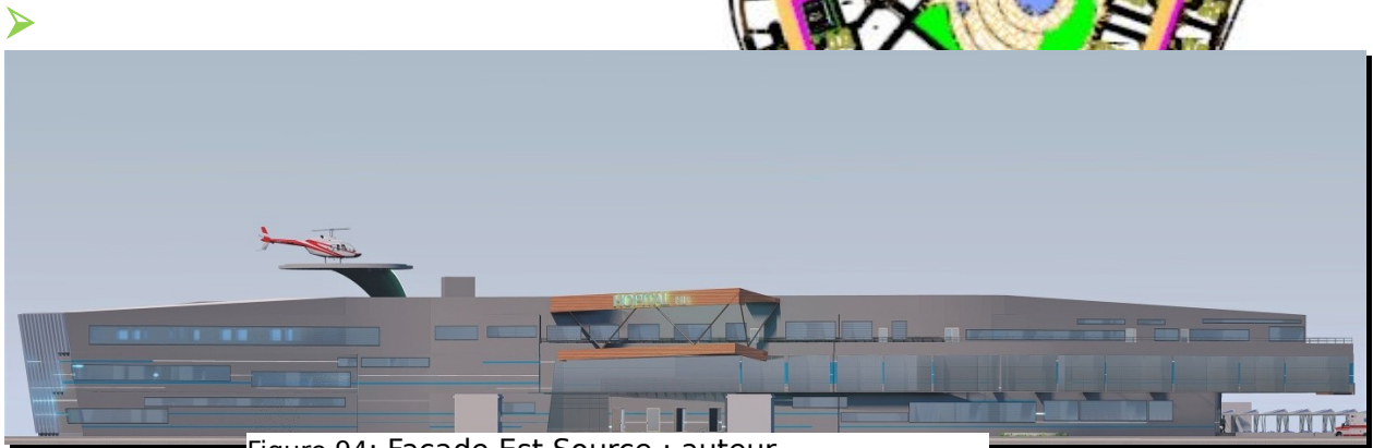
Figure 94: Façade Est Source : auteur
