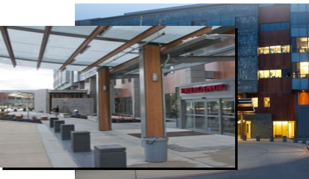
Figure 13: Entrée principale de l'hôpital Source : archdaily.com
