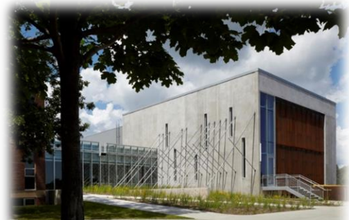
Figure 2. 17: bâtiment de génie civile UMD Swenson. Source : https://www.archdaily.com/ .
