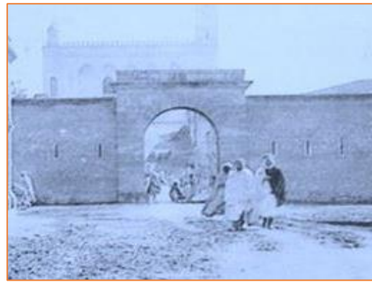
Fig.II.07 : Les remparts de Ksar
