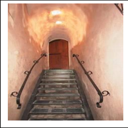
الشكل(89): استخدام درج حديدي لإظهار الدرج القديم
