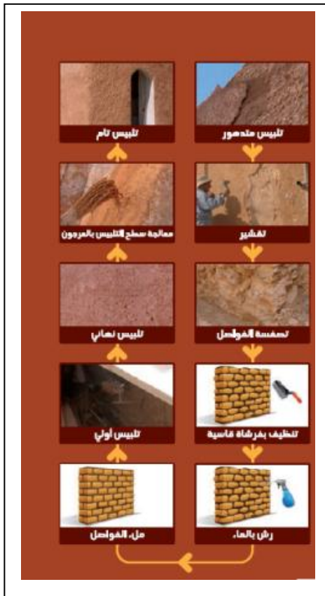
الشكل (142): إعادة تلييس الواجهات.
