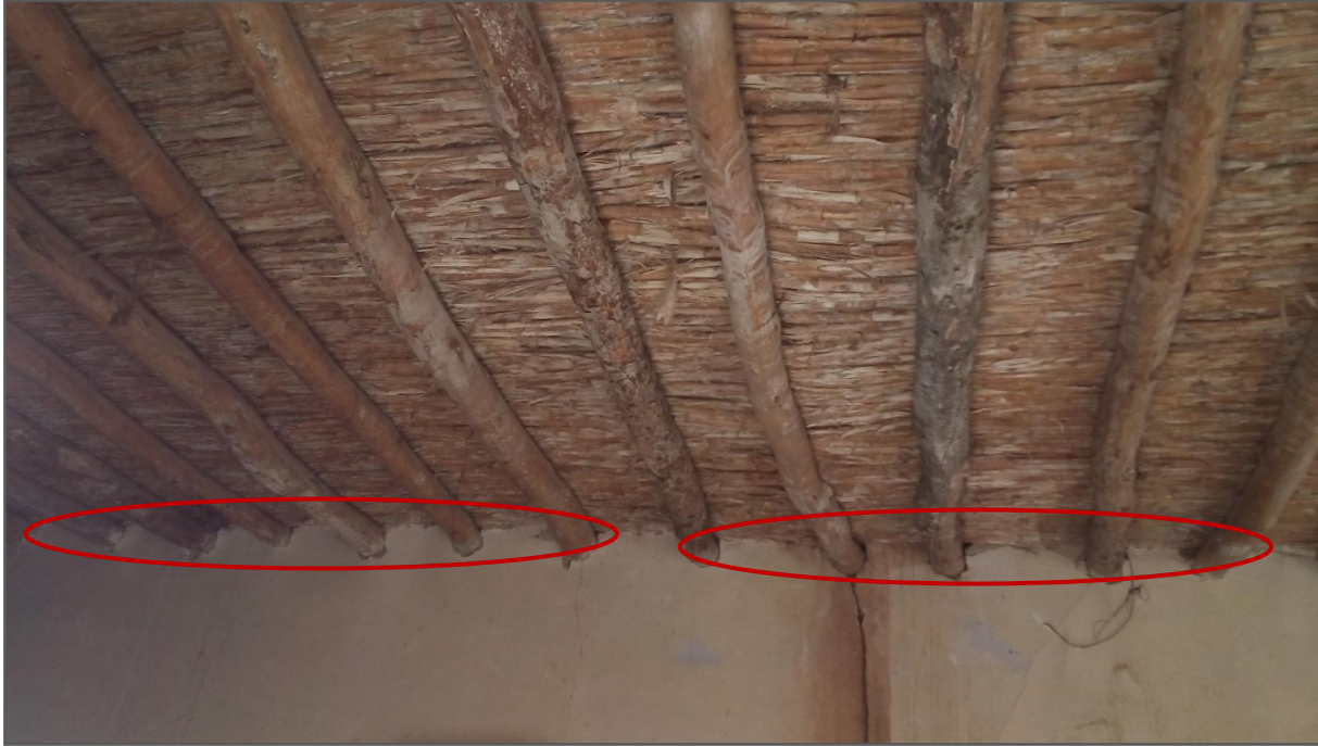
الشكل(145): صورة توضح تلف بطرف عارضة السقف. المصدر :من إعداد الطالبتين.
