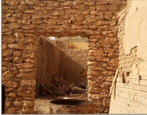
الشكل 116: جدران مبنية بالحجارة
