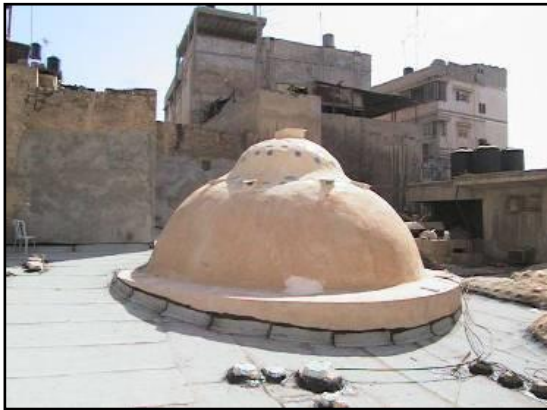
الشكل(79): القببة التي تغطي الفراغ الرئيسي.
