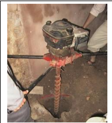
الشكل(90): إجراء فحص للأساسات لمعرفة أسباب الهبوط
