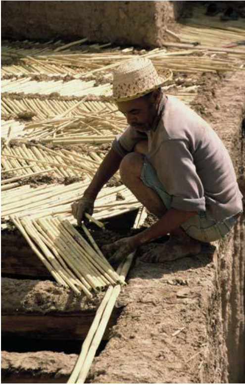
الشكل (147): صورة لطريقة إعادة وضع الحصير خلال عمليات الترميم. المصدر: دليل منهجية ريهابيمد للعمارة التقليدية المتوسطة إعادة التأهيل على مستوى المبنى ص 383
