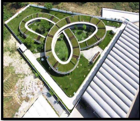
الفصل 1 صورة35: سقف المشروع
