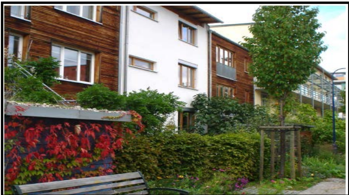
Photo26.La récupération eaux de pluie / source:/www.vauban.de
