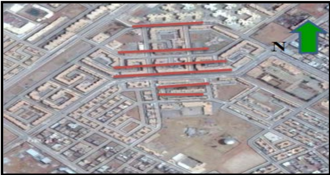
— Façade orienté nord
