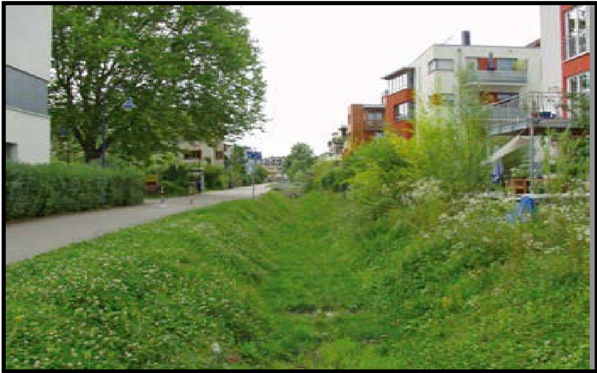
Photo25./ Caniveau eaux source:/www.vauban.de
