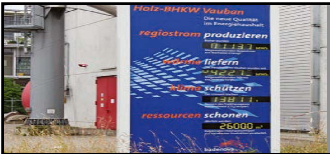
Photo22.Centrale à cogénération/ source:/www.vauban.de
