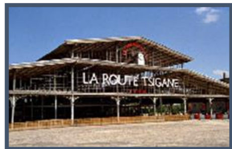
Figure (74): Grande Halle source: wikipédia.org
