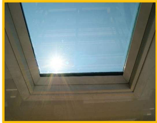
Figure 2-6 Puits de lumière. Source : www.energie.arch.ucl.ac.be
