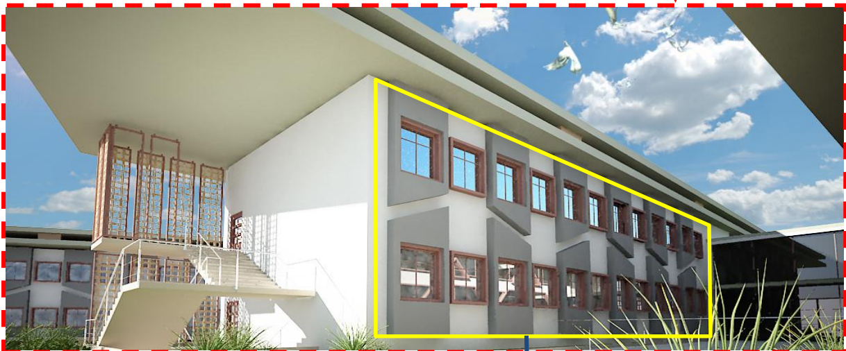
Figure 5-33 la façade des salles de classe. Source Auteur
