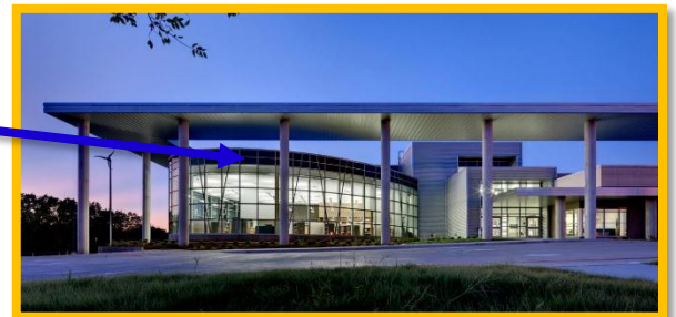
Figure 1-7 les façades de l'équipement. www.ArchDaily.com
