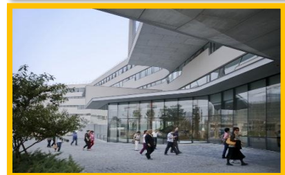
Figure 1-24 les façades de l'équipement. www.ArchDaily.com
