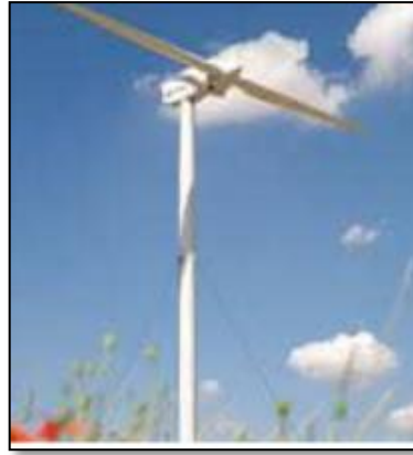
Figure N°10 : éolienne à axe horizontal de type bipale.
