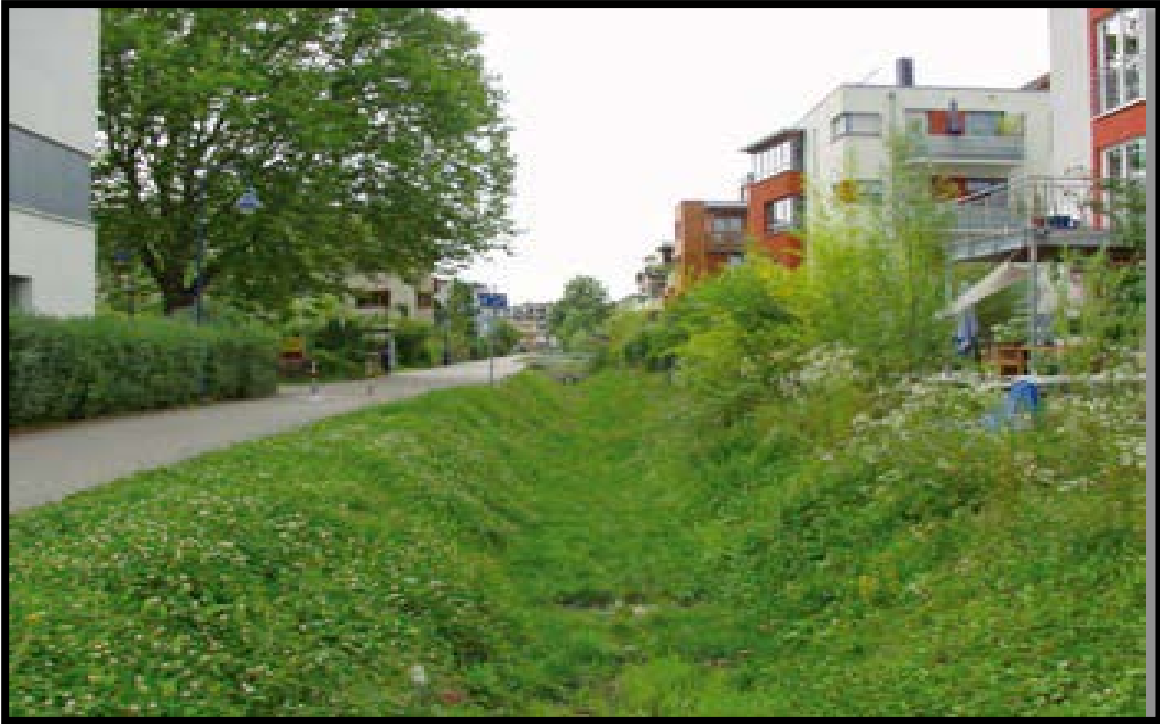
Photo25./ Caniveau eaux source:/www.vauban.de
