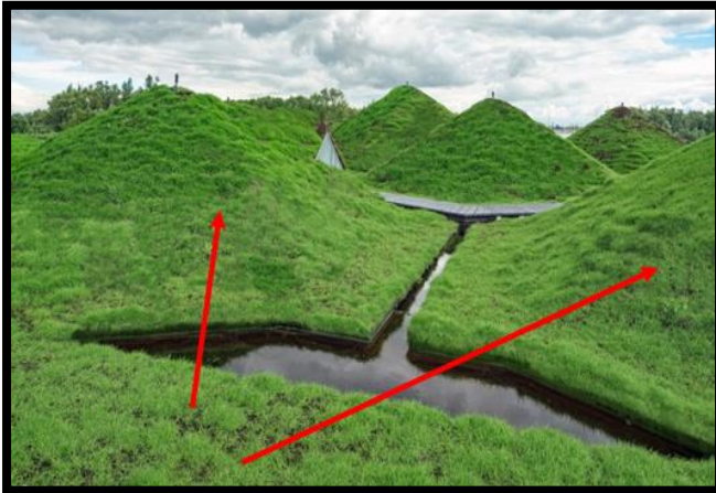
FigureII.4: toiture végétalisée du musée Source: archidaily.com
