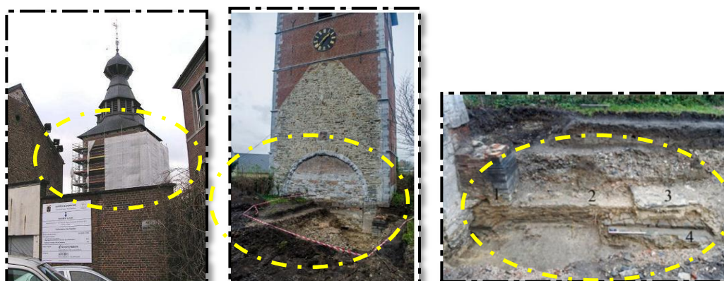
Planche 3 : quelques photo de travaux de restauration et des fouilles archéologiques réalisés. Source : Villes Historiques en Développement, des Clés pour Comprendre et Agir.
