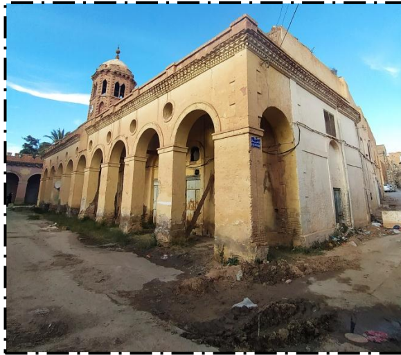
Photo7 : l'état du beffroi de Laghouat actuellement. Source : auteur, 2020
