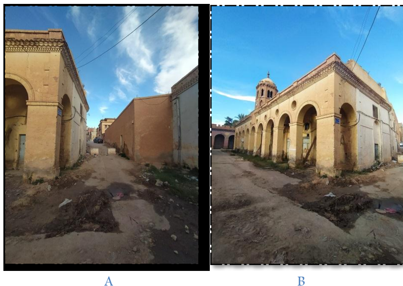
Figure 2 : stagnation des eaux usées .source : auteur.
