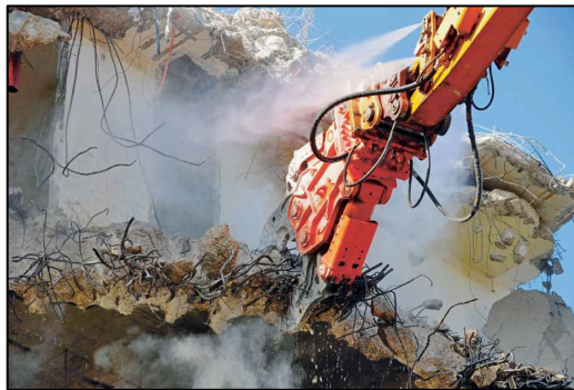
Figure I.14: Démolition à l'aide d'une tenaille [14]
