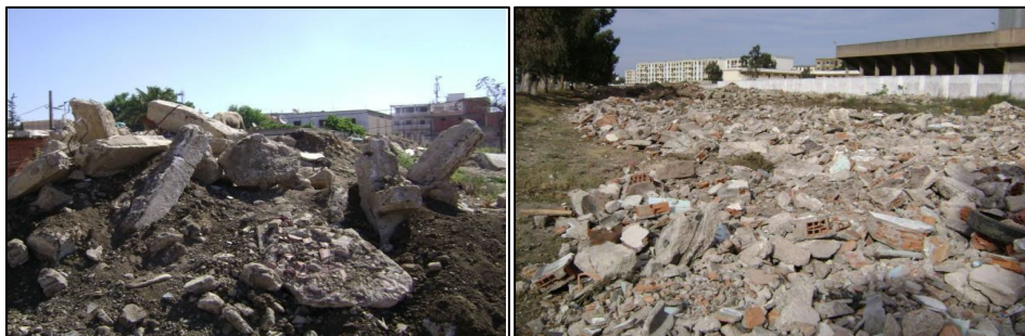
Débris de bétons
