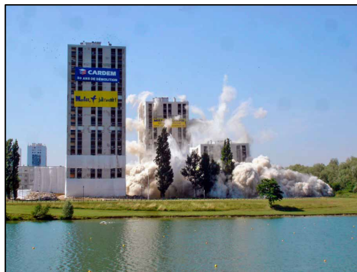
Figure I.15: Démolition par dynamitage [14]
