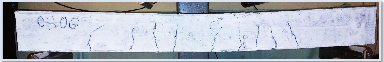
Figure III.12 : Schémas de fissuration de la poutre témoin 1 (BT1S0G0).
