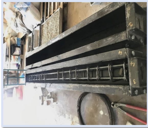
Figure II.27 : Coffrage métallique des poutres.
