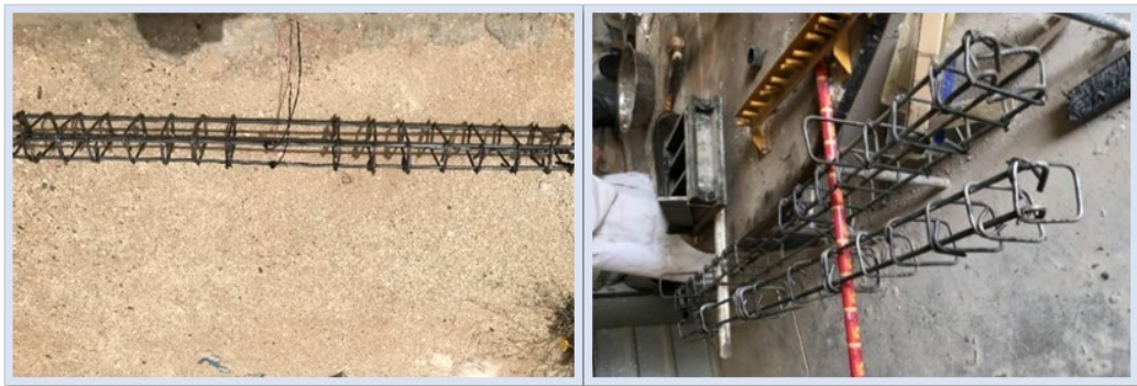
Figure II.28 : Ferrailage des poutres.
