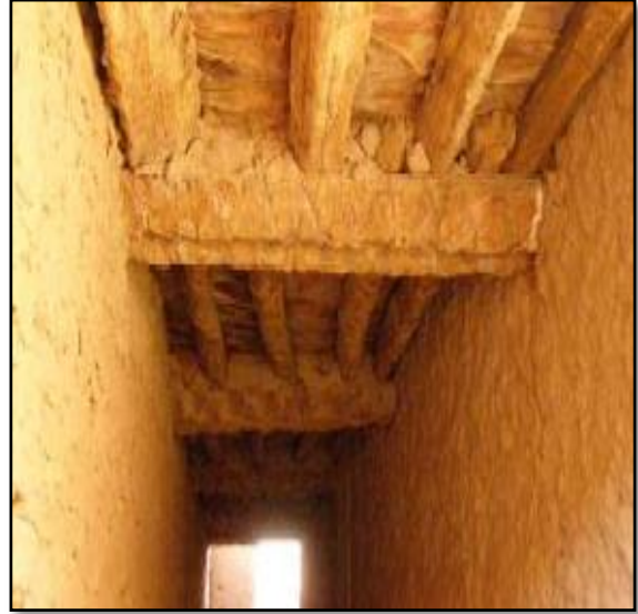
الشكل رقم 15: صورة لتوضيح تقنية التلبيس المصدر : أرشيف الصور من الحضيرة الوطنية للاهقار
