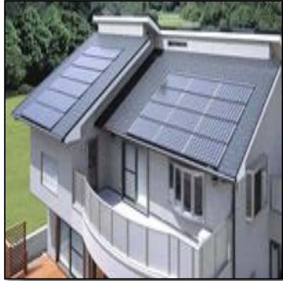
الشكل رقم 4 : صورة توضح منزل يستخدم الطاقة الشمسية المصدر: http://www.emkanat.org/solar_energy/
