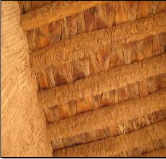
الشكل رقم 16: صورة لتوضيح تقنية التلبيس المصدر : أرشيف الصور من الحضيرة الوطنية للاهقار
