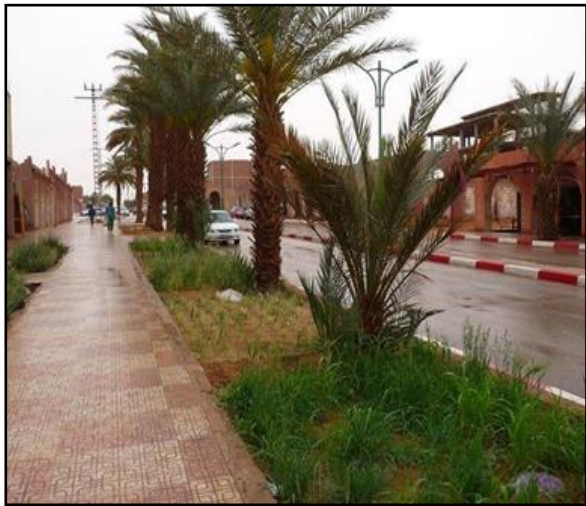
الشكل رقم 30 : صورة توضح ضياع المياه وسط الطرق الرئيسية للمدينة المصدر : ملتقطه من طرف الطلبة
