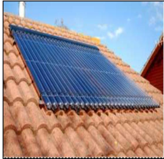
الشكل رقم 6: صورة توضح المسطح التجميعي للأنايبب الزجاجية المصدر: http://www.feedo.net/scienceAndTechnology/solarEnergy.htm
