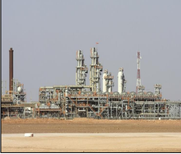
الشكل رقم 33 : صورة لوحدة انتاج الغاز المصدر : ملتقطه من طرف الطلبة
