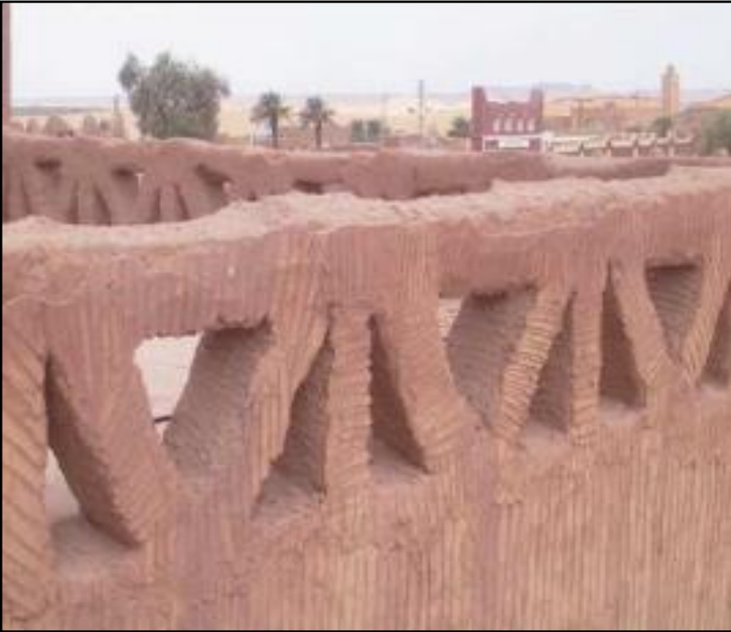
الشكل رقم 14: صورة لتوضيح تقنية التلبيس المصدر : أرشيف الصور من الحيضيرة الوطنية للأهفار
