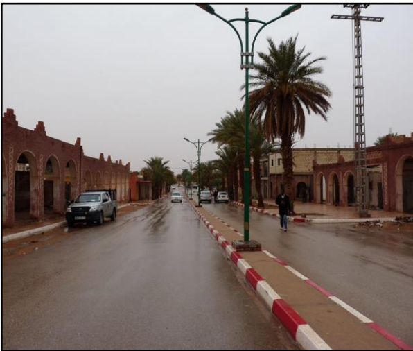
الشكل رقم 31 : صورة توضح ضياع المياه وسط الطرق الرئيسية للمدينة المصدر : ملتقطه من طرف الطلبة
