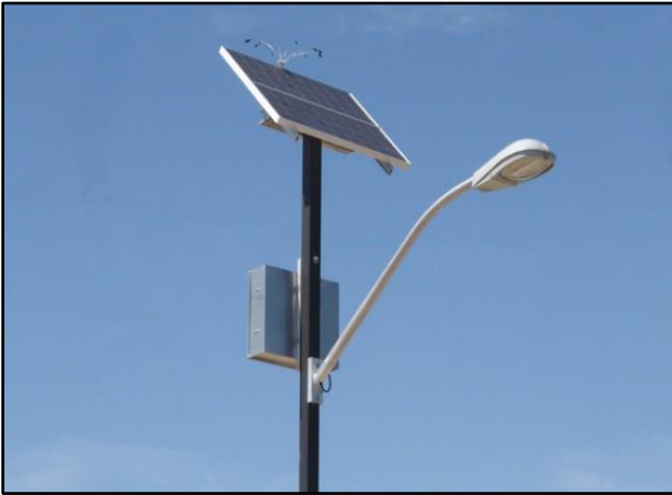
الشكل رقم 10 :صورة توضح تموضع الألواح الشمسية فوق الأعمدة الكهربائية
