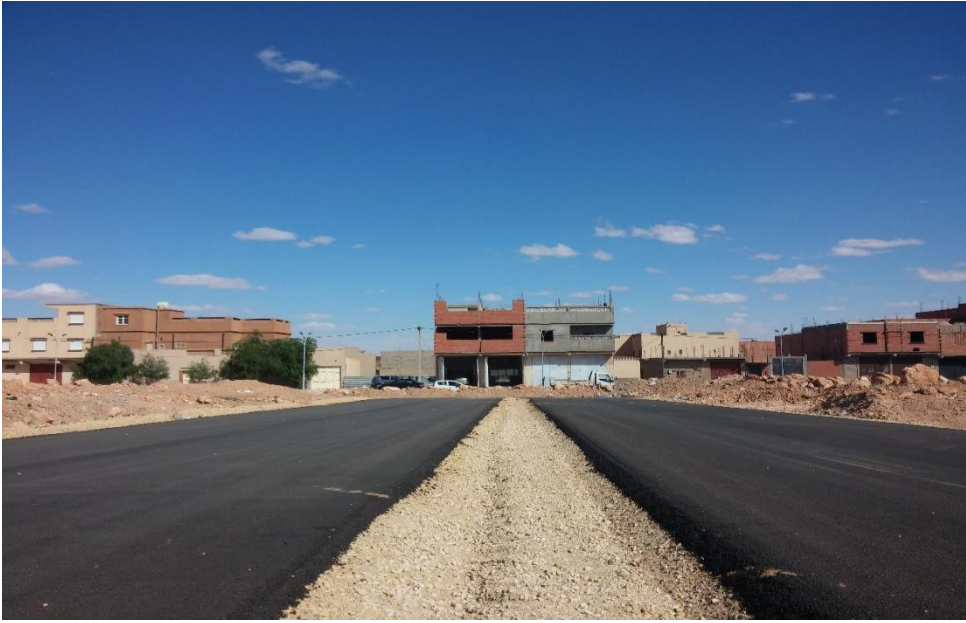
صورة (67) – توضح الطريق المنجزة بأرضية المشروع المصدر: من النقاط الطلبة
