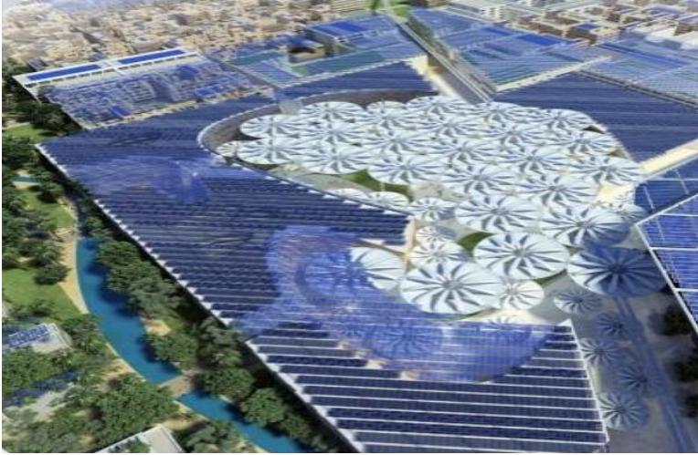
صورة (١٨) - استخدام مسطحات واسعة من الخلايا الشمسية
