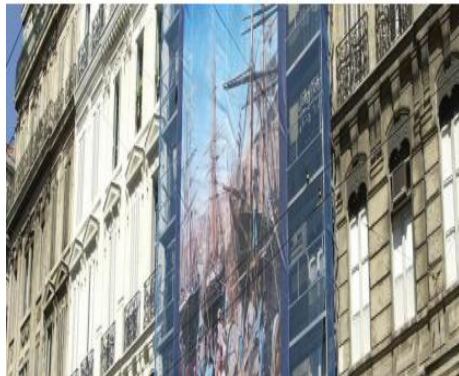
صورة رقم (17): ترميم الواجهات
