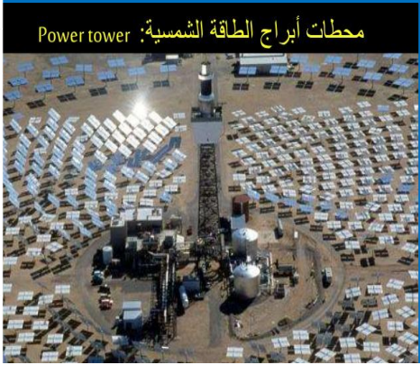
محطات أبراج الطاقة الشمسية: Power tower صورة رقم 02: تمثل محطات ابراج الطاقة الشمسية
