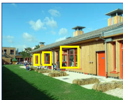
Figure 46: façade de l'école maternelle. Source : batirama.com
