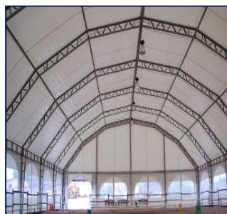
Figure 158: poutre en treillis. Source : www.slideshare.net
