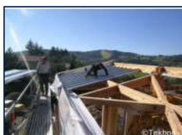
Figure 79: bac acier (la toiture). Source : Reportage_chantier_montrottier_VAD.pdf
