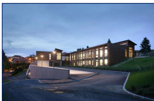
Figure 76: Façade nord-ouest. Source : Reportage_chantier_montrottier_VAD.pdf
