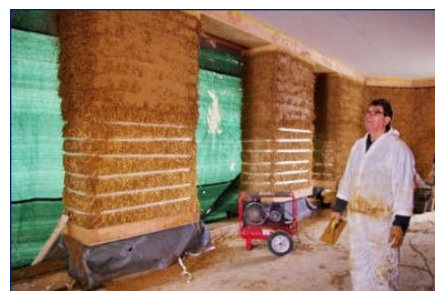
Figure 47: botte des pailles sur les murs. Source : batirama.com
