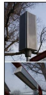
Figure 12 : éclairage solaire abri de bus
