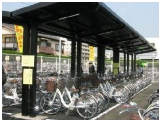
Figure 15 : Station de recharge solaire pour les vélos électrique Source : archiexpo.fr/
