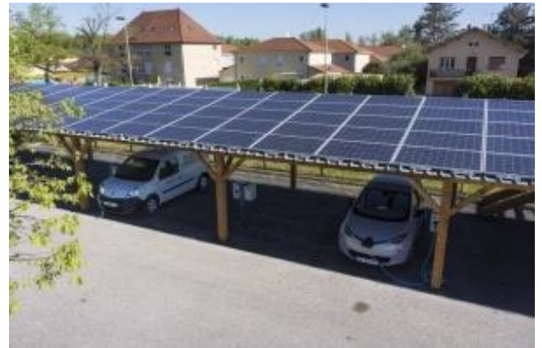
Figure 14 : Station de recharge solaire économique pour voiture électrique Source : sud-energies-alternatives.fr
