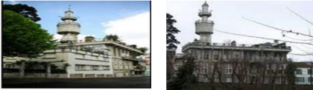
Fig I.1. Villa témoin en béton armé de François Hennebique à Bourg la Reine construite entre 1894 et 1904 [4]
