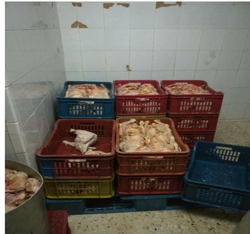
Photo : de conservation de viande de volailles dans la chambre froide
