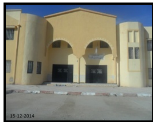
Figure 90: Ecole Omran Tayeb a Ain-Ouessara [Source : prise par auteurs]
