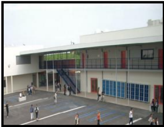
Figure 32 : Vue sur la façade intérieure Source : Mémoire fin de formation en HQE. Claire Martin. Ecole d'architecture Lyon .2006
