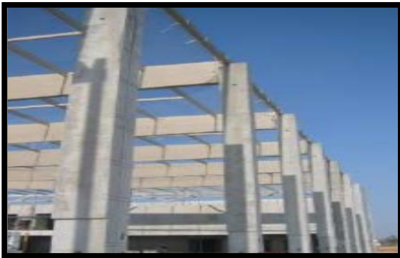
Figure 109: ossature en béton armé [Source : http://www.calcia-infos.com ]
