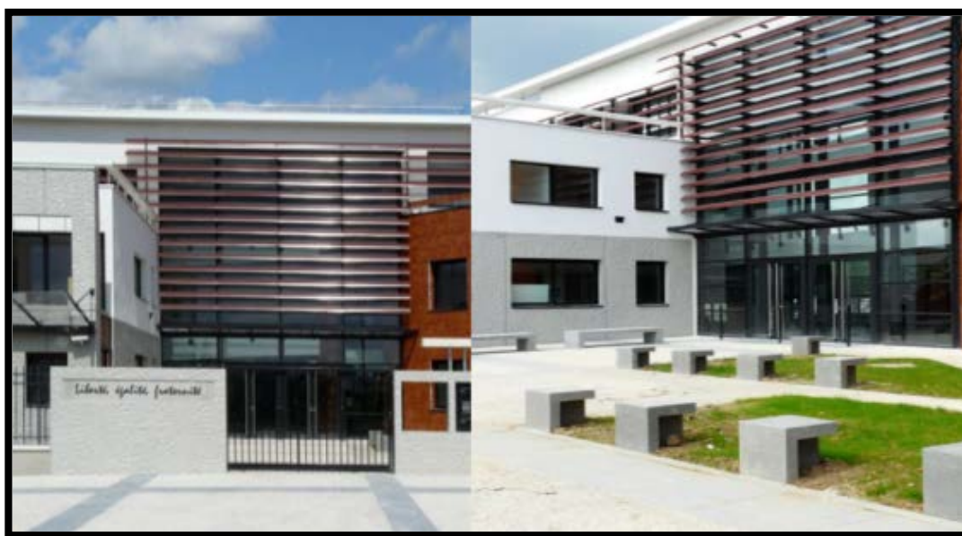
Figure 63 : façade sud-ouest (Store a lame orientable) [Source : http://www.Atlas des colleges.com ]
