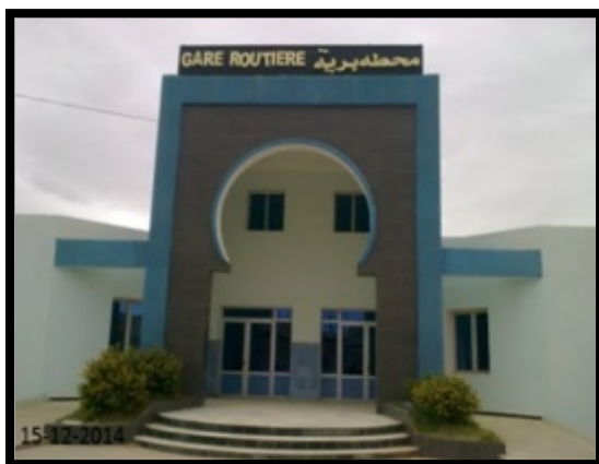
Figure 89 : Gare routière d'Ain-Ouessara [Source : prise par auteurs]
