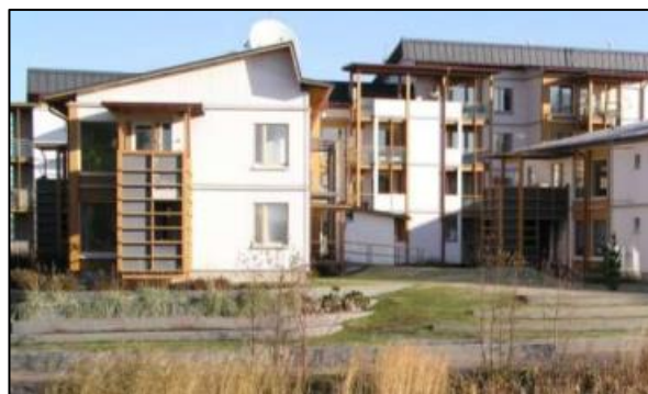
Figure 24: des constructions en bois.
