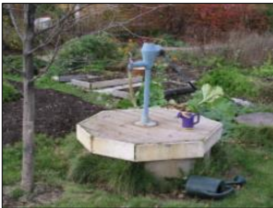
Figure 23: Une pompe à main utilisant les eaux de ruissellement.
