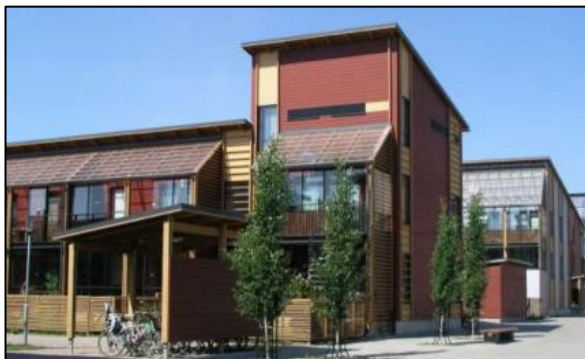
Figure 25: des constructions en bois.
