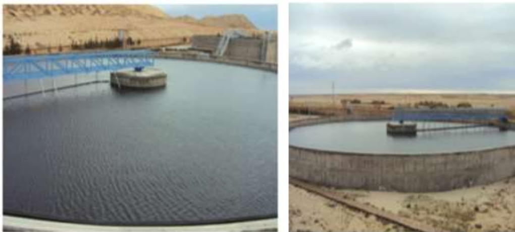
Figure I- 5 La décantation STEP de Laghouat ( Photo personnelle, 2018 ).
