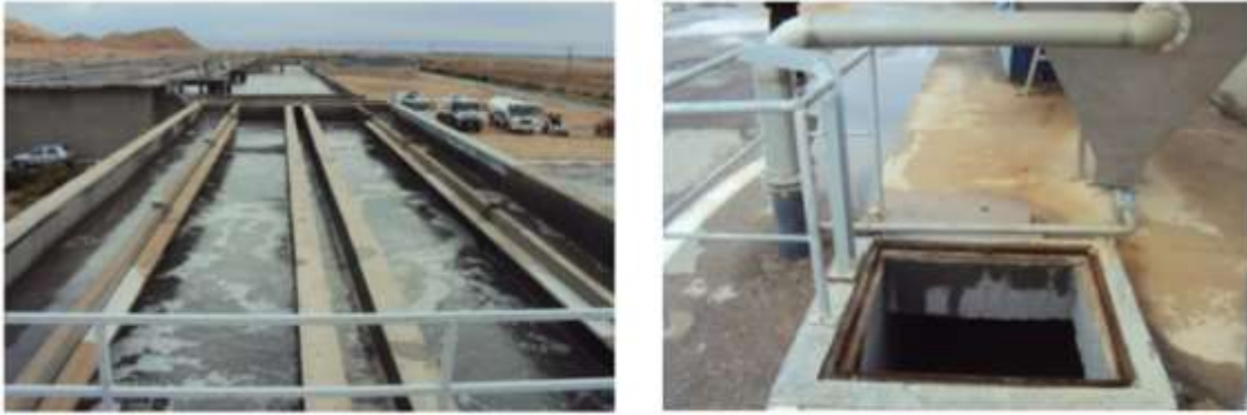
Figure I- 4 le déshuilage STEP de Laghouat ( Photo originale, 2018 ).
