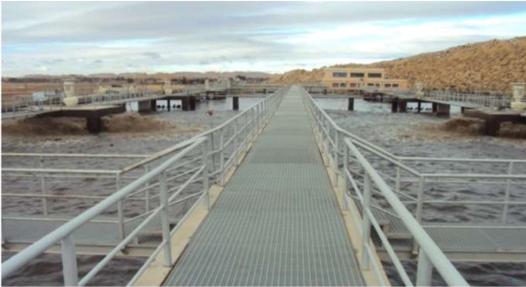
Figure I- 7 Le traitement biologique STEP de Laghouat ( Photo Originale, 2018 ).
