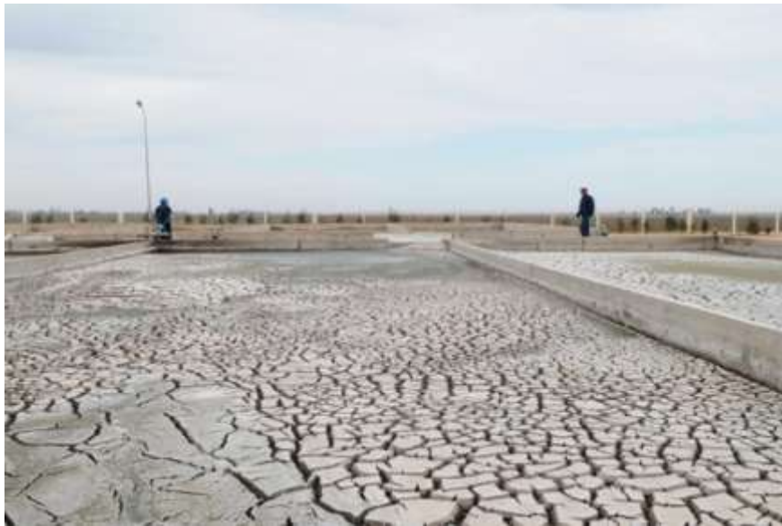
Figure I- 8 Un lit de séchage STEP de Laghouat ( Photo originale, 2018 ).
