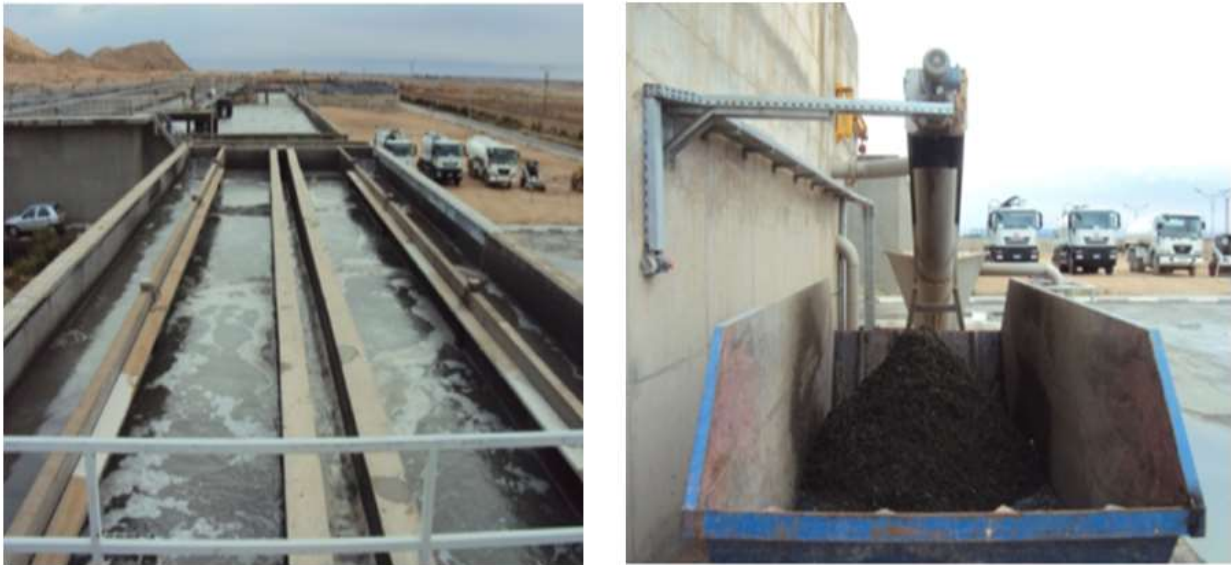
Figure I- 3 le dessablage STEP de Laghouat ( Photo originale, 2018 ).
