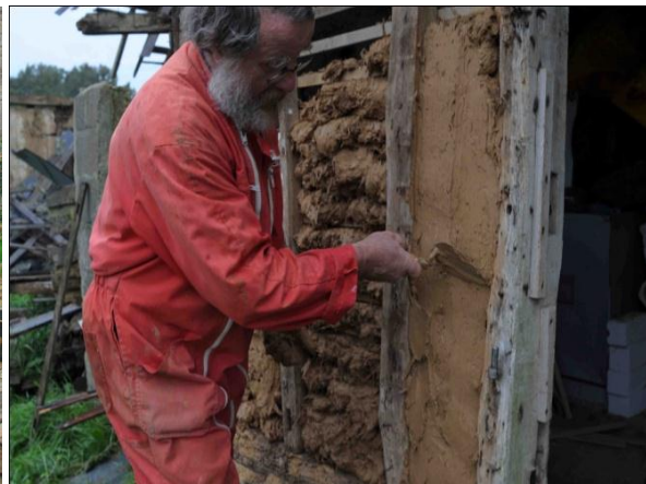
Photo. I.13 : Construction d'un mur [13].
