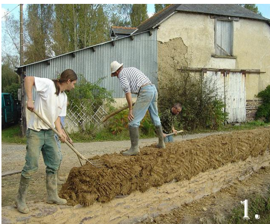
Photo I.10: Construction en bauge en 1982 à Cesson-Sévigné. [1]
