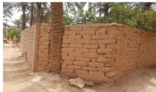
Photo I.9 : Construction en Adobe
