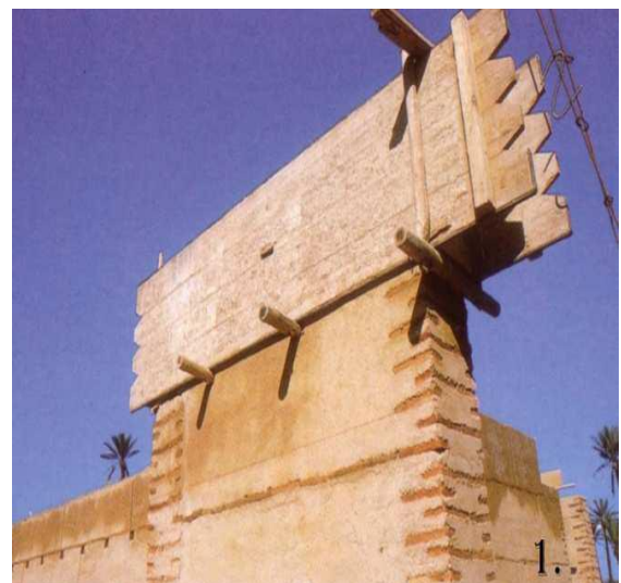
Photo I.5: Remplissage d'un mur en pisé au Maroc [1]
