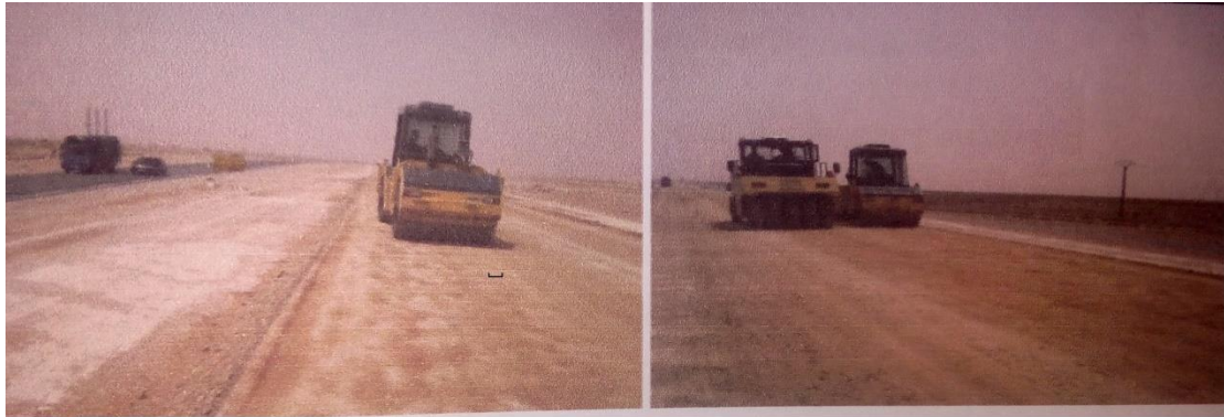
Photo I. 1 Réalisation de dédoublement RN 01 entre LAGHOUAT-GHARDAIA
