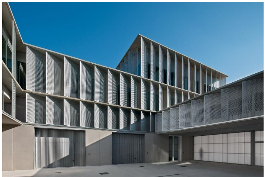
Figure 33: Entrée principale du projet Source : www.archdaily.com
