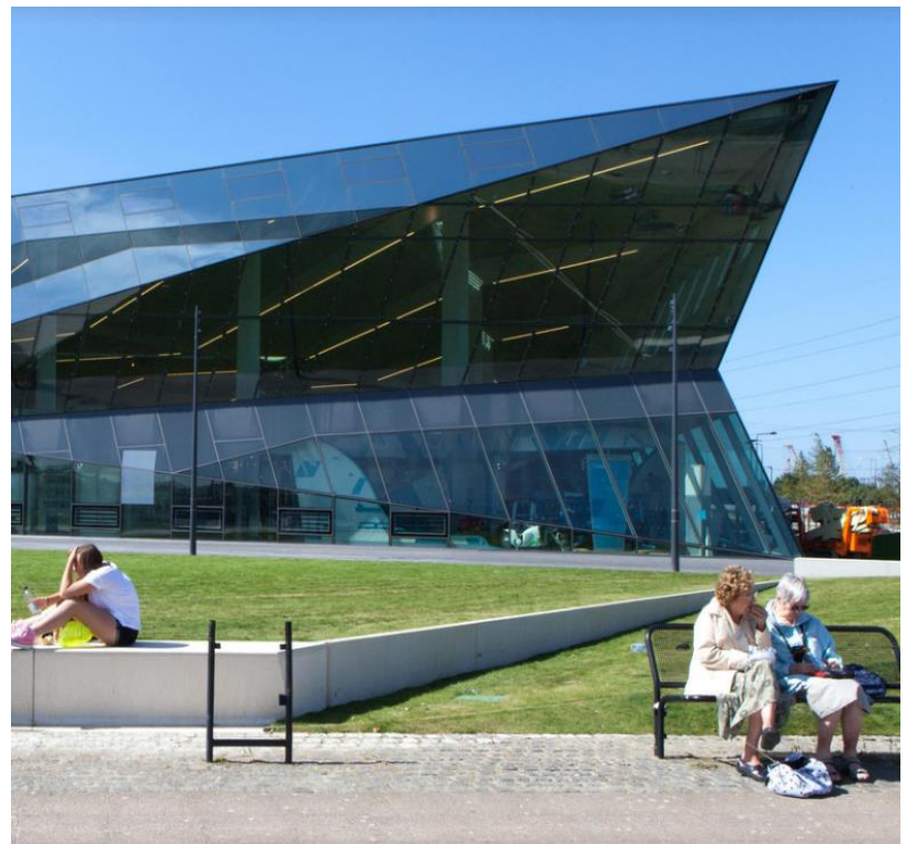
Figure 75: Entrée principal du projet Source : www.archdaily.com
