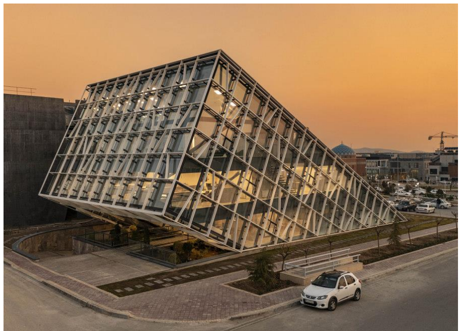
Figure 50: Vue d'ensemble sur le projet Source : www.archdaily.com
