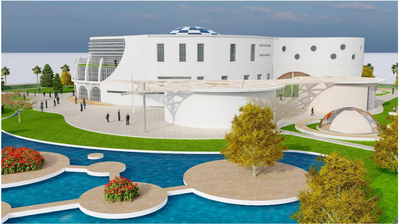
Figure 207: façade sud-ouest Source: auteur.
