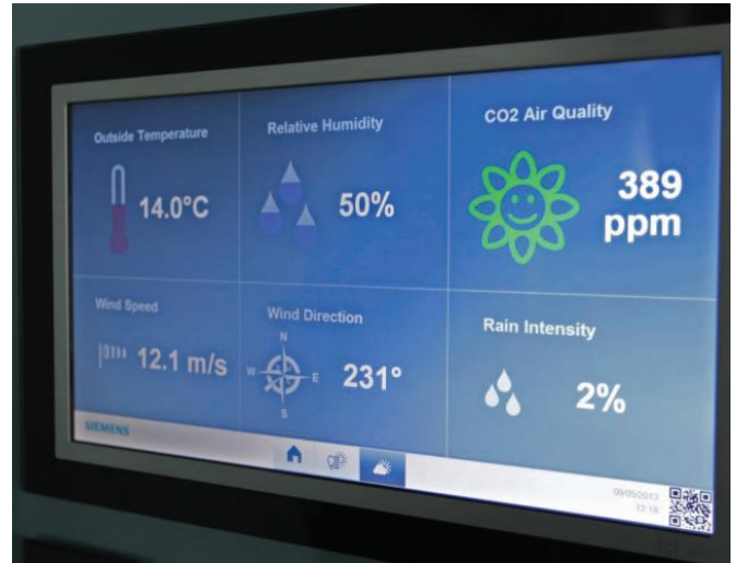
Figure 82: La gestion de l'énergie du bâtiment Crystal. Source : www.wilkinsoneyre.com
