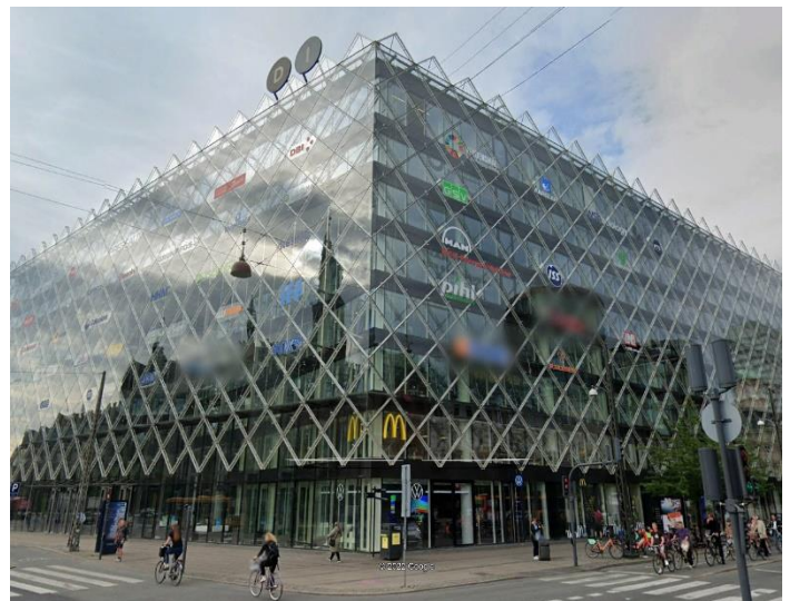
Figure 93: Le bâtiment de la Confédération Des Industries Danoises. Source : https://stateofgreen.com
