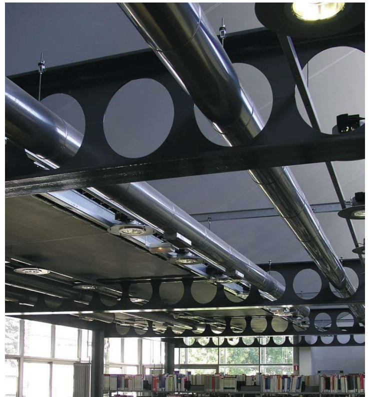
Figure 220: Poutre cellulaire Source: www.archiexpo.fr
