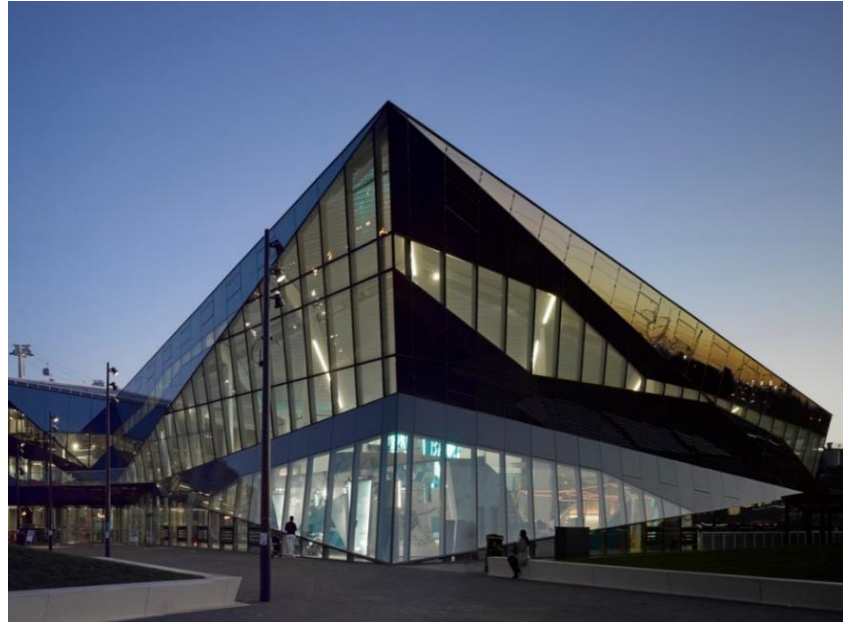
Figure 74: Entrée principal du projet Source : www.archdaily.com
