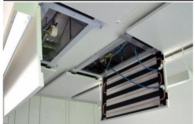
Figure 233: Détail du plafond froid. Source: energieplus-lesite.be
