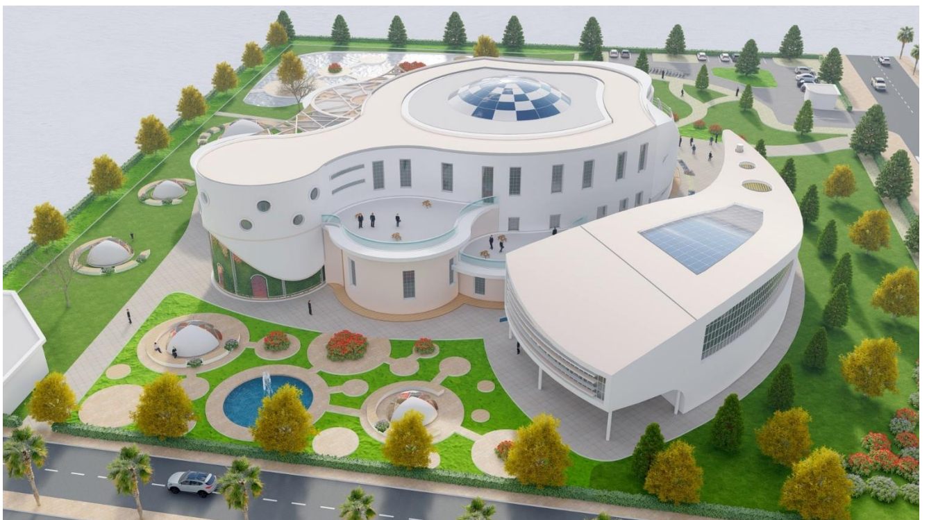
Figure 208: façade nord Source: auteur.
