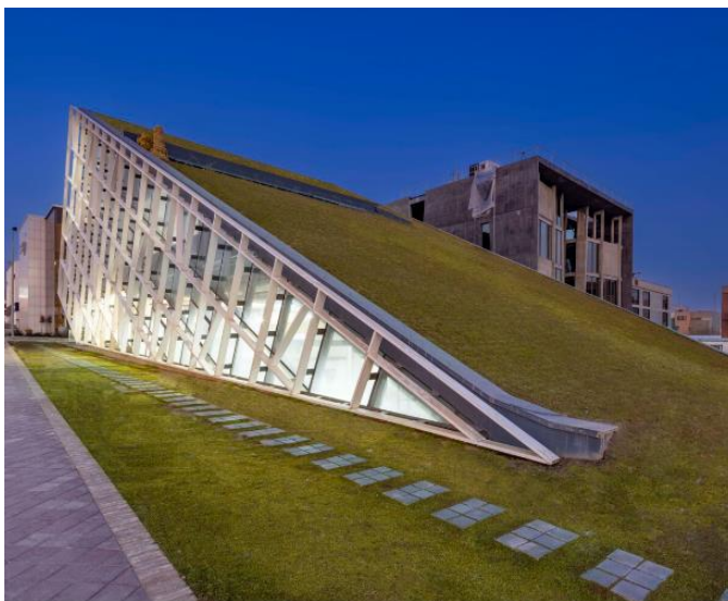
Figure 73: Vue sur Le toit incliné. Source : www.archdaily.com
