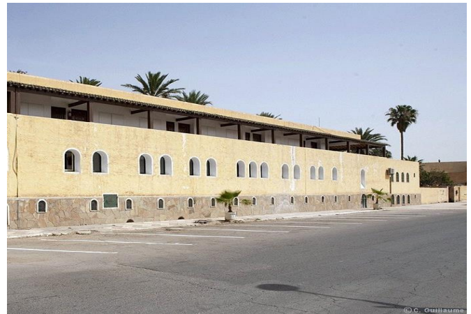
صورة رقم (07): الواجهة الأمامية قبل الأشغال (تصوير الطالب)
