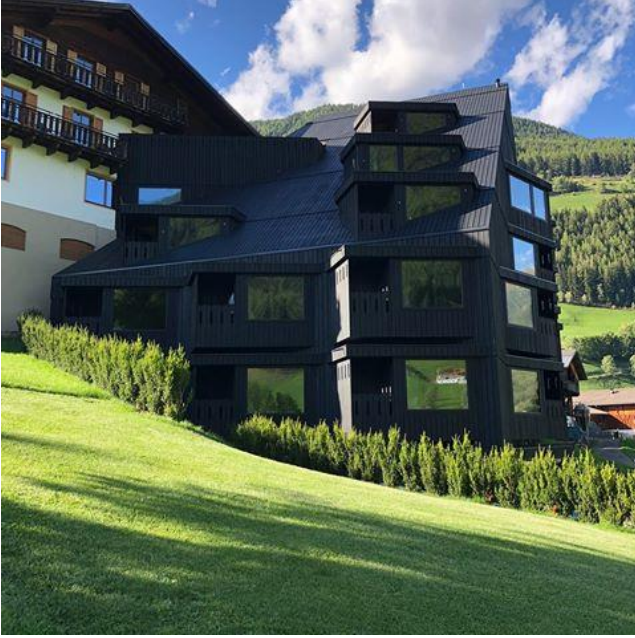
صورة رقم (31): واجهة التوسعة في الجهة المنحدرة
