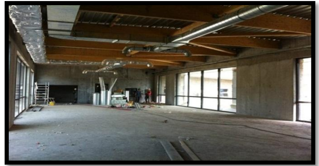
Fig. 46 : Utilisation du bois, Source : http://www.archdaily.com
