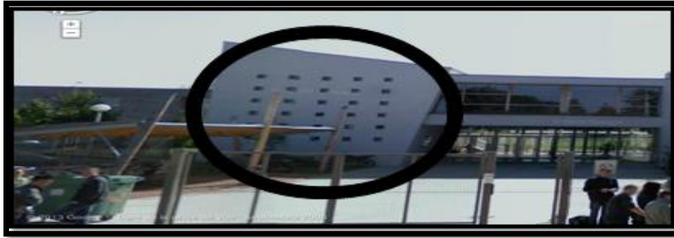
Fig.I.19 Photo de la façade de lycée côté sud
