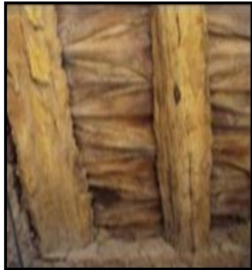
صورة رقم 143: سقف مشيد من جذوع وجريد النخل المنصورة القديمة صورة رقم 144: سقف مشيد من عوارض فولاذية
