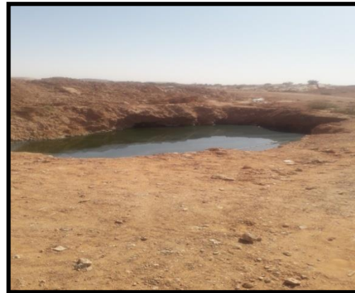
صورة رقم 169 و 170 : لحفر تجميع المياه القذرة ممتلئة ويتم إفراغها من طرف مصالح البلدية
