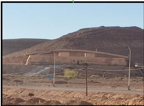
صورة رقم 93: خزان المياه
