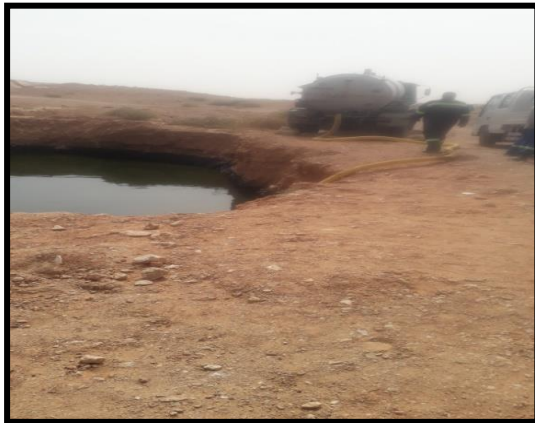
صورة رقم 169 و 170 : لحفر تجميع المياه القذرة ممتلئة ويتم إفراغها من طرف مصالح البلدية
