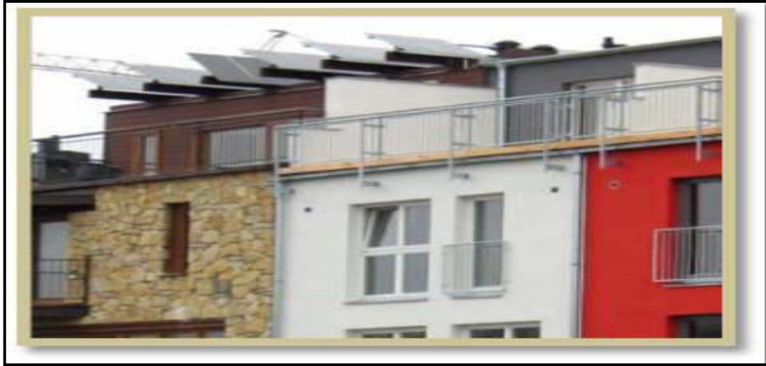
Figure N 34 : Les capteurs solaires Source : Quartier Durable, guide d'expérience européenne
