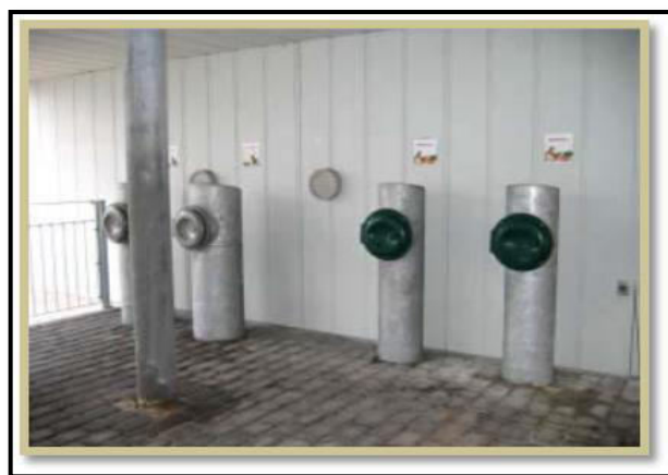
Figure N 32 : le système de vide ordures pneumatiques Source : Quartier Durable, guide d'expérience européenne
