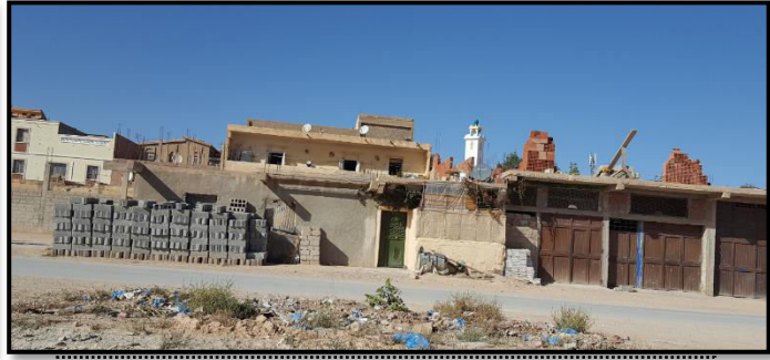
Figure N 45 : les Habitats individuelles / source : auteurs
