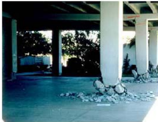
Figure 26: Rotules plastiques des poteaux [16]
