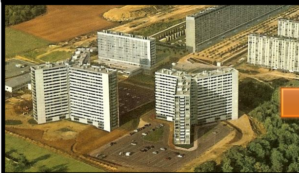
هدم المباني "عمارات"
