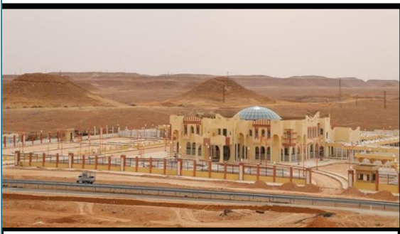
الشكل رقم: 53 صورة لمحطة المسافرين المصدر : Google earth
