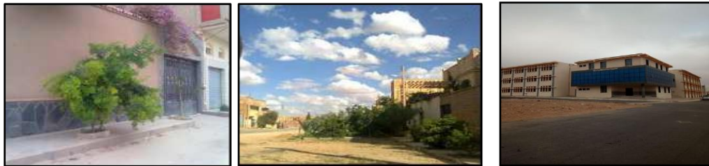
Figure II 38: Le gabarit est varié entre RDC et R+1 de l'habitat individuel. [Source : Auteurs].
