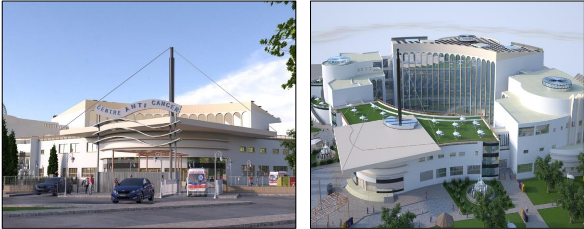
Figure IV 1: Façade principale nord de projet. [Source : Auteurs].
