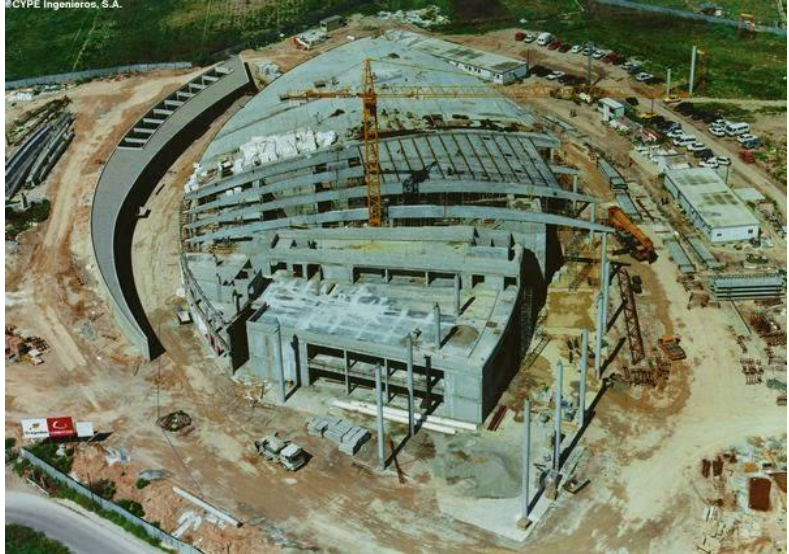
Figure 28 : centre de conférence Valence en cours de construction
