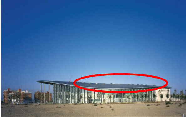
Figure 36 : les puits de lumière
