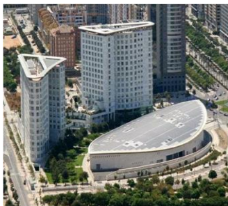
Figure 30 : Mur trompe de centre de conférence valence
