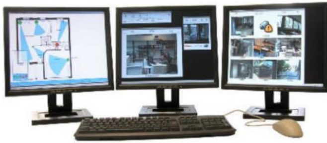
Figure 149 : Moniteurs de surveillances
