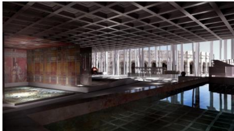
Figure 110 : Dalle à caissons (cassette)
