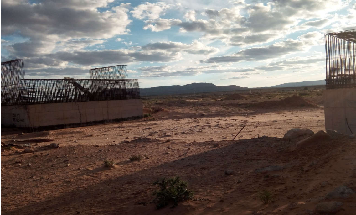
Figure V. 10 : coupe longitudinale de pont au cours de réalisation
