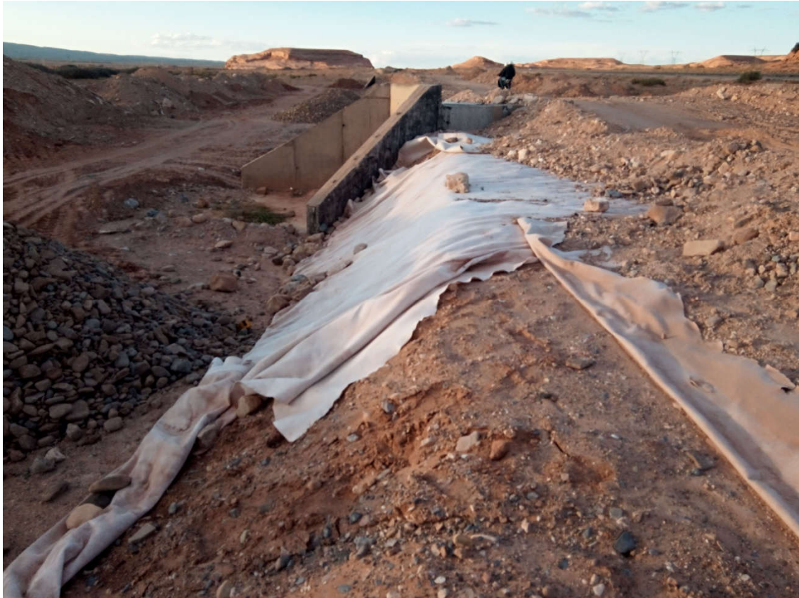
Figure V. 13 : photo réel de remblai en noyau central
