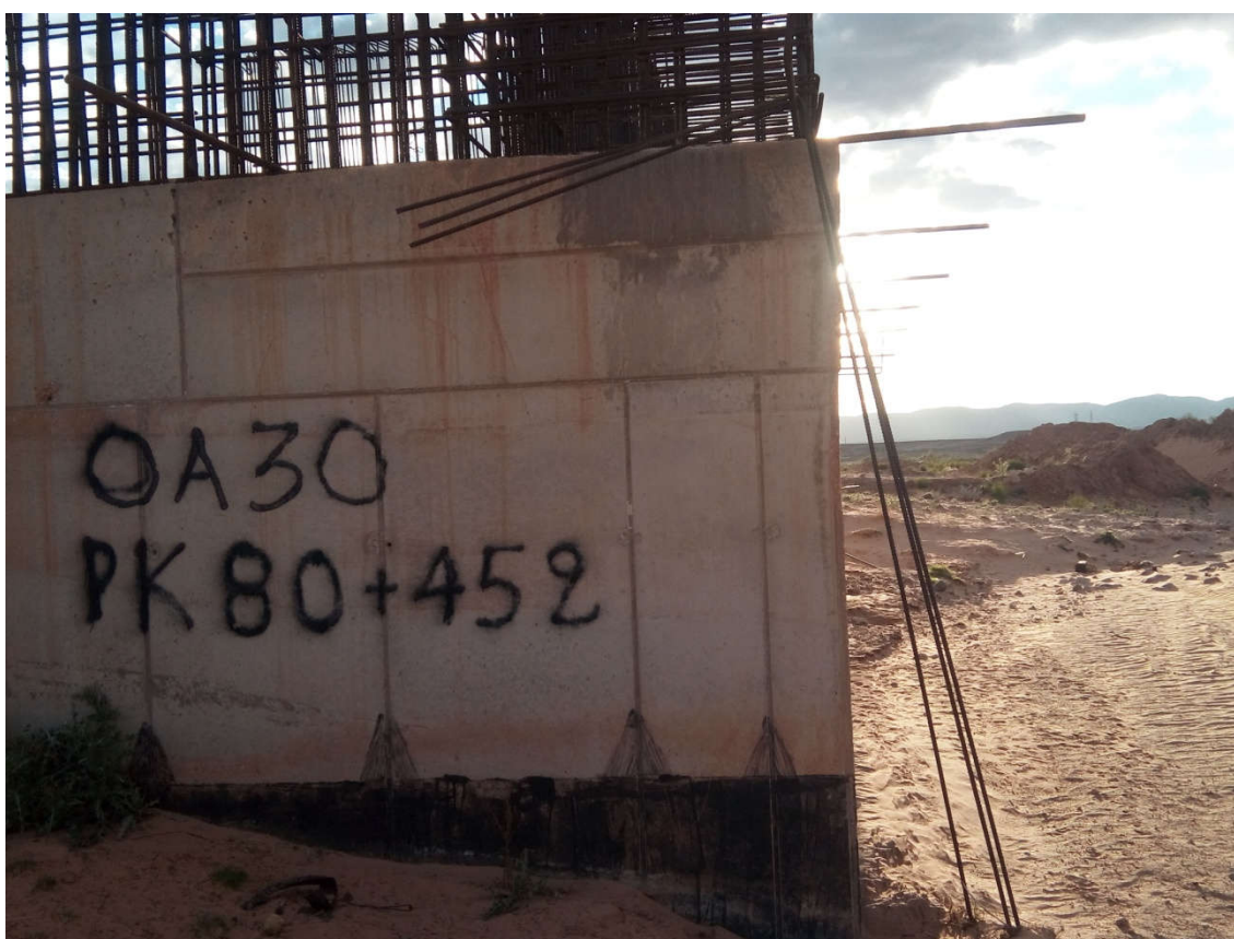
Figure V. 7 : Photo reel de culée
