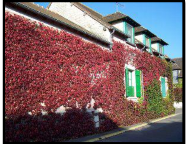
Mur couvert par de la vigne
