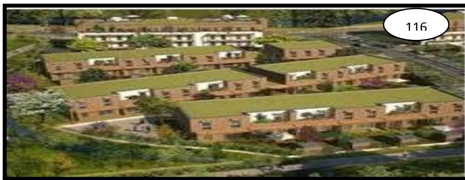
Photo116 : Terrasses végétale (Source : auteurs).
