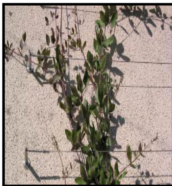
Système de câblages
