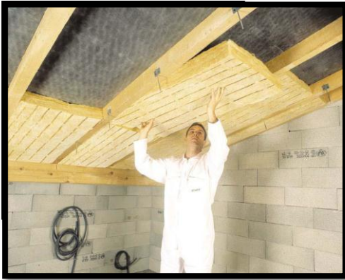
Photo125 : représente Les laines minérales (Source : auteurs).
