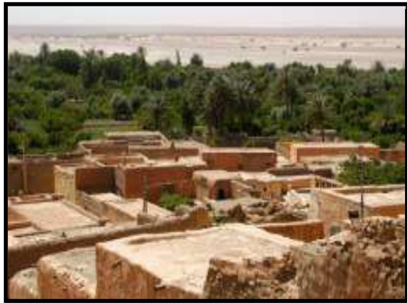
الشكل (05): صورة لقصر تاجموت
