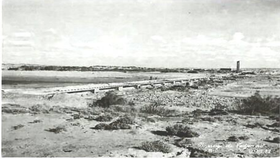
Le barrage d'inféro-flux du Haut M'zi en fin de construction en 1952. Seule est appavente la partie supérieure de l'ouvrage qui plonge dans le sol jusqu'à la rencontre du « bed-rock » à 6, 8, 10 mètres de profondeur.
