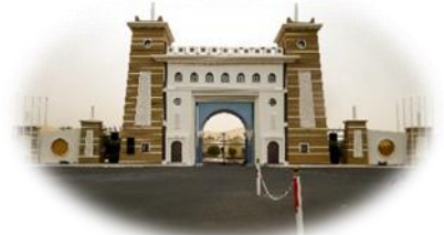
الشكل 33: صورة للمدخل
