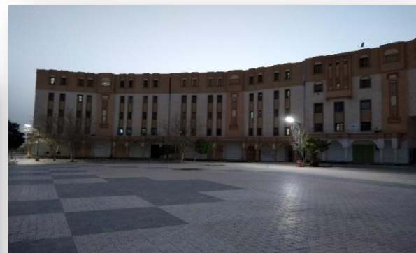
Figure 45 : Blocs Résidentiels R+4
