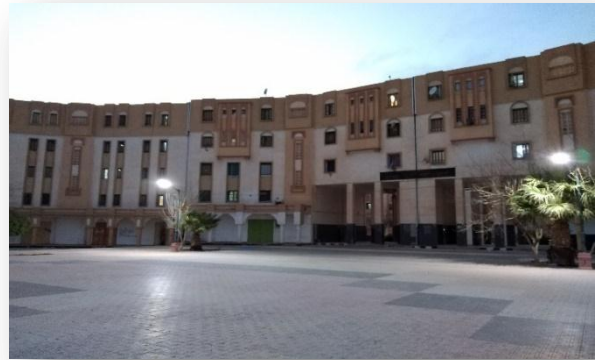
Figure 44 : Blocs Résidentiels R+4
