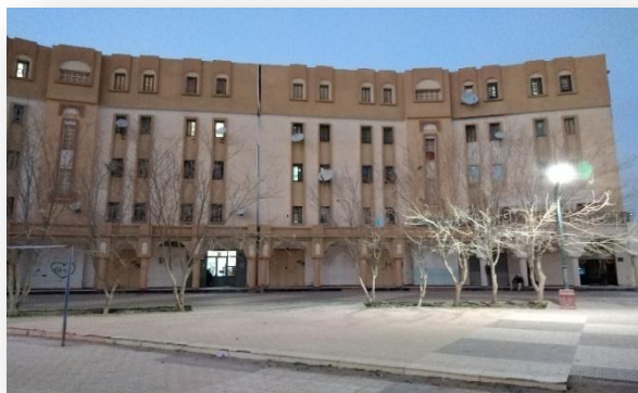
Figure 46 : Blocs Résidentiels R+4
