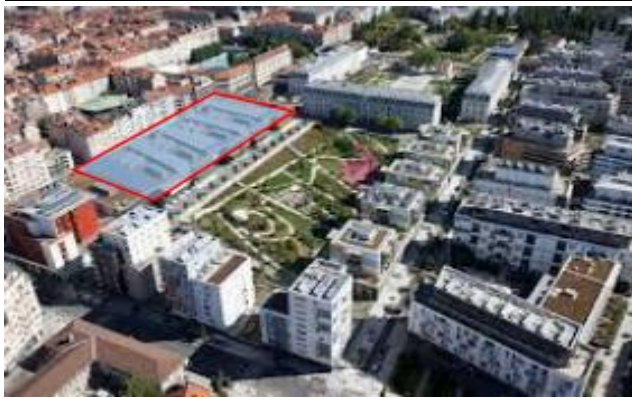
Figure 30 : les panneaux photovoltaïques sur le côté commerciale
