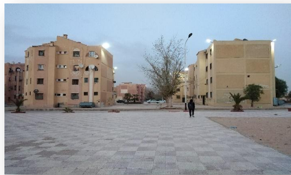
Figure 47 : Bloc résidentiel en R+3, activité commerciale absente, style architecturale classique Source : Auteur
