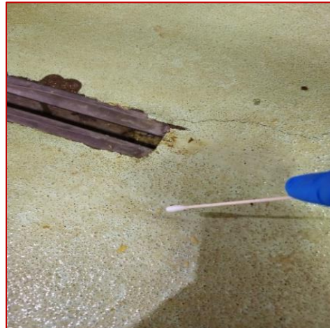
PHOTO 3: écha .de la surface de sol (Photos personnelles)
