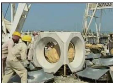
L'utilisation des blocs de béton
