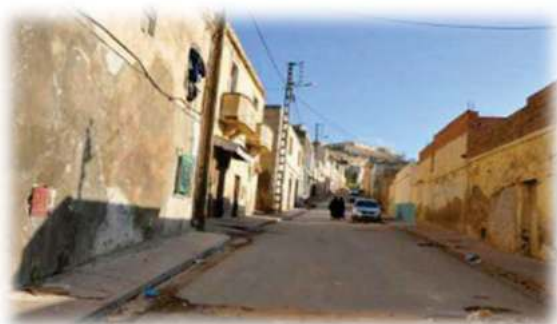
Photo 55: état dégradé d'habitat Source : étudiantes
