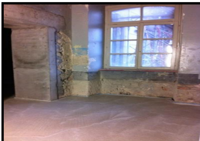
Figure I.36 : Les murs sont en moellons de grès jaune et en calcaire les murs Source : CRFBA
