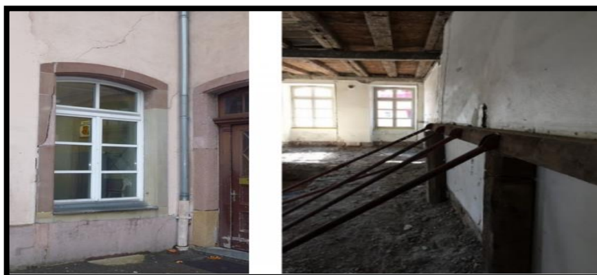
Figure I.37 : Consolidation du mur en cours de chantier Source : CREBA
