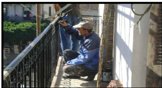
Figure I.33 : Peinture du garde-corps métallique Source : MEMOIRE de M. AIT HAMOUDA Ibrahim 2012 - 2013
