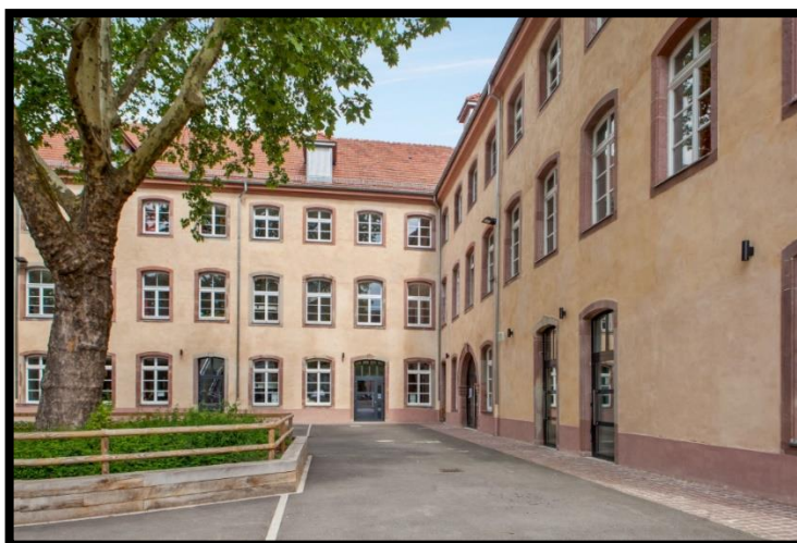
Figure I.40 : Bande de pavés entre l'école et l'enrobé de la cour de récréation Source : CREBA
