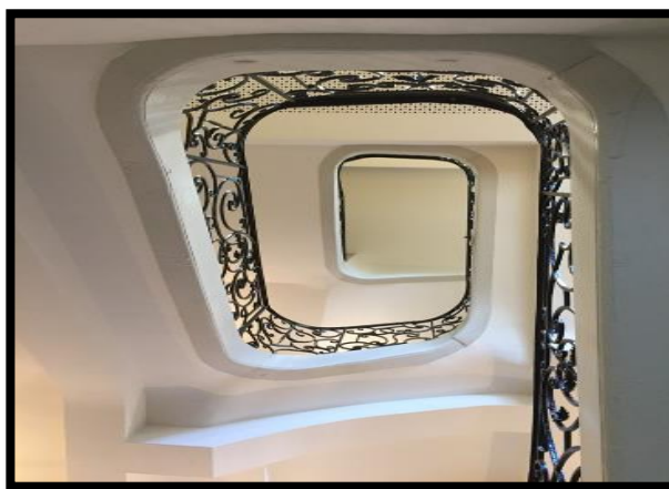
Figure I.41 : Renforts en sous-face de l'un des deux escaliers protégés Source : CREBA
