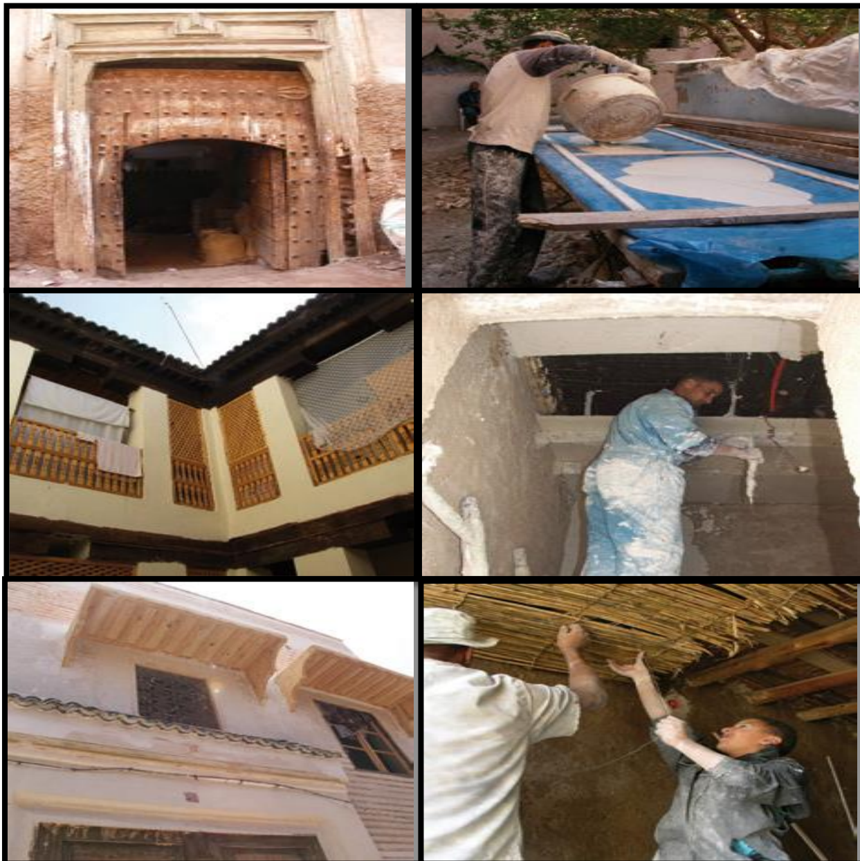
Figure I.52. : Construction de faux plafonds et Restauration des éléments en menuiserie Source : RehabiMed, Réhabilitation et action sociale à Marrakech, Maroc
