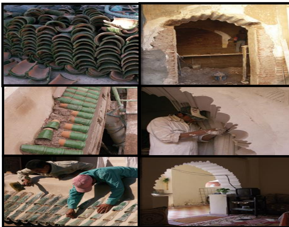
Figure I.53. : Restauration des auvents et Récupération des arcs et inscriptions Source : RehabiMed, Réhabilitation et action sociale à Marrakech, Maroc
