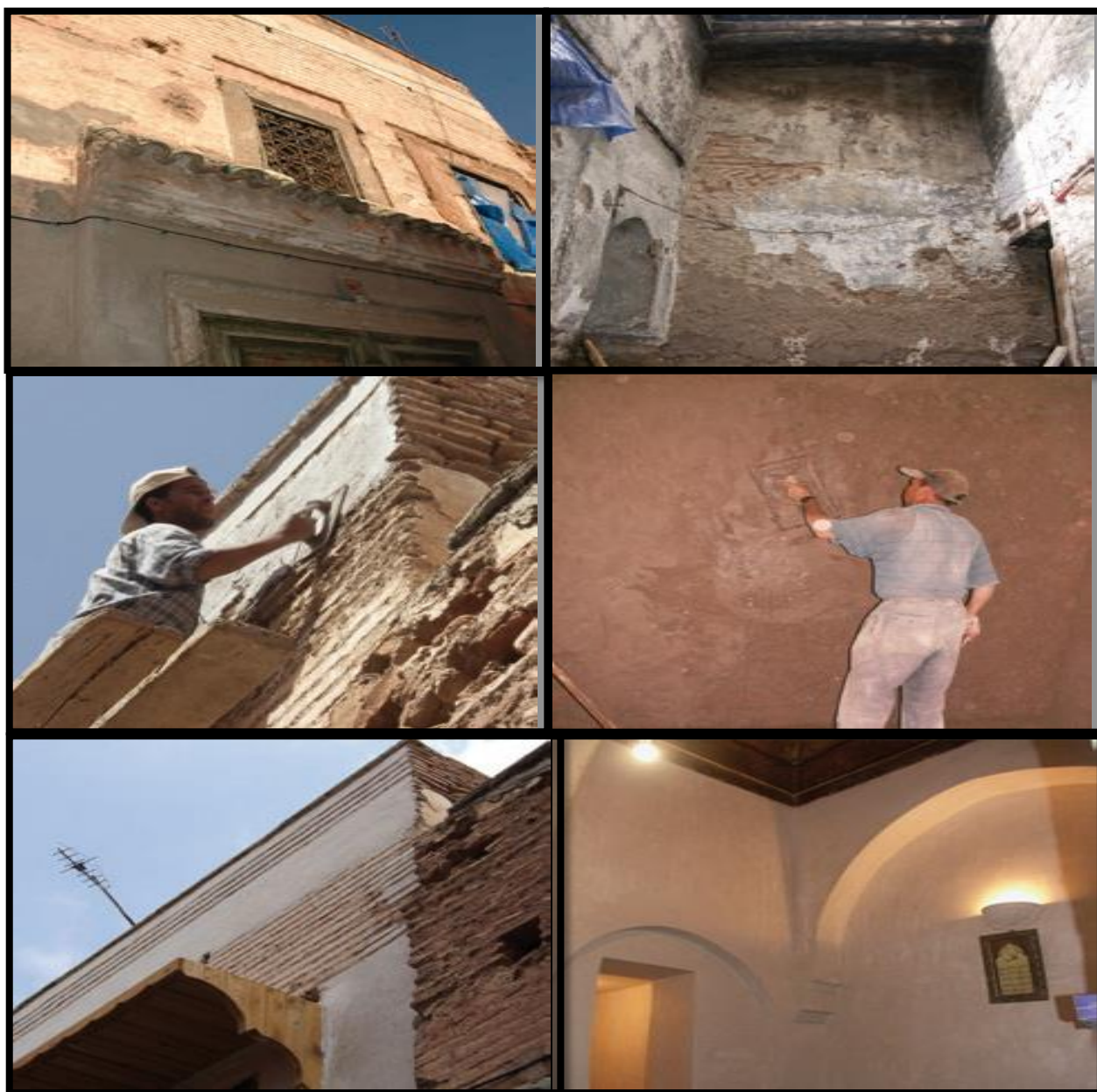
Figure I.51. : Réfection des enduits intérieurs et Restauration des façades extérieures Source : RehabiMed, Réhabilitation et action sociale à Marrakech, Maroc
