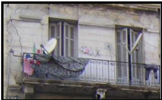
Figure I.28 : Présence d'une fissure Source : MEMOIRE de M. AIT HAMOUDA Ibrahim 2012 - 2013
