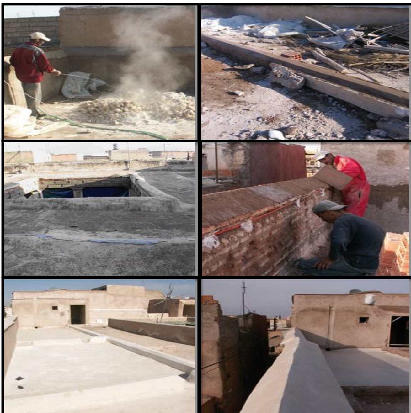
Figure I.48. : Reprise des parapets et acrotère et Reprise de l'étanchéité Source : RehabiMed, Réhabilitation et action sociale à Marrakech, Maroc
