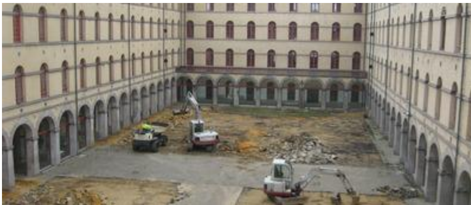
Photo 09 : Le projet en chantier -Source : www.pss-archi.eu
