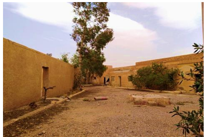
Photo 34 : représente la cour de la caserne Source : Auteur
