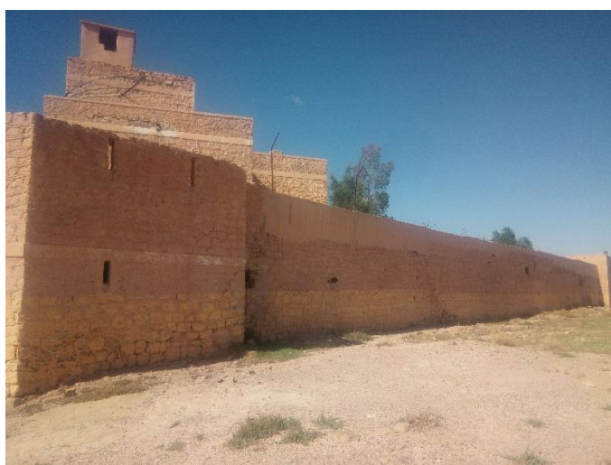
Photo 45 : la façade droite en bon état Source : pris par l'auteur
