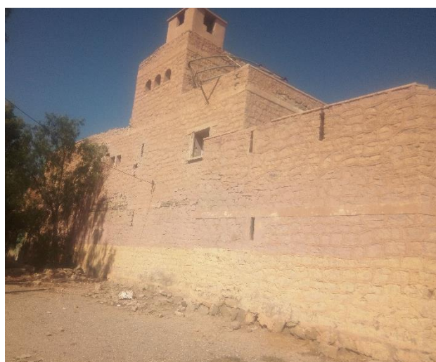
Photo 44 : la façade principale en bon état Source : pris par l'auteur
