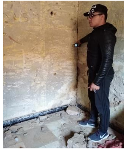
Photo 32 : mesures avec le distomètre - Source : Auteur
