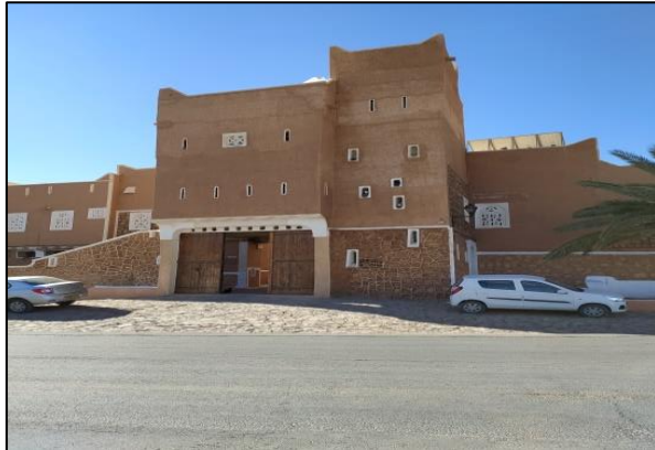
الشكل 22 :صورة توضيحية لبرج عند مدخل القصر
