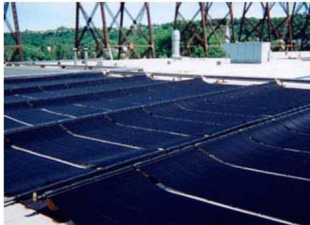
Fig ( I.11) : Capteurs plans non vitrés. [15]
