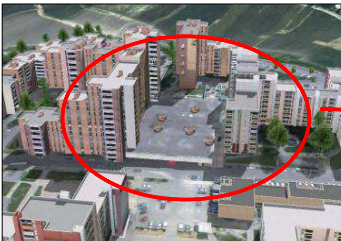
Figure 37. Le centre du quartier avant la démolition. Source : 18_AmenagementUrbainDevelopement Durable.pdf, p : 13
