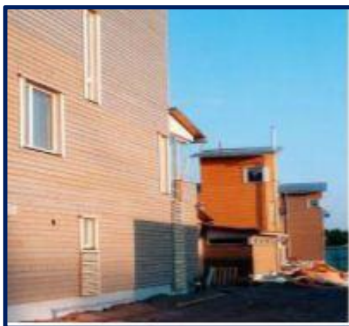
Image 10 : logement transformable du quartier viikii. [9]
