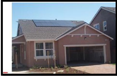
Image 1 : Intégration des panneaux photovoltaïques sur Une partie de la toiture en pente [4]
