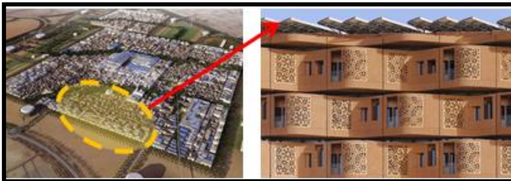
Image 3 : d'installation des panneaux photovoltaïques sur les toitures terrasse (Masdar city) [5]
