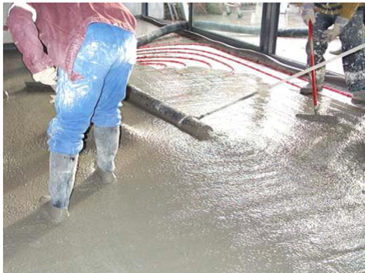
Fig. I.2 : Mise en place du BAP par un ouvrier.
