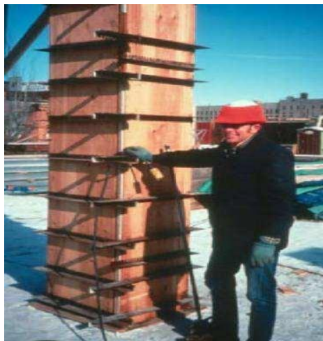
Fig.II.8 : Maintien des coffrages en place.
