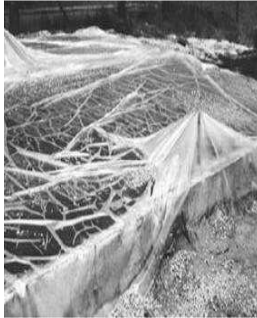
Fig. II.7 : Usage d'un polyane recouvrant la surface du béton.
