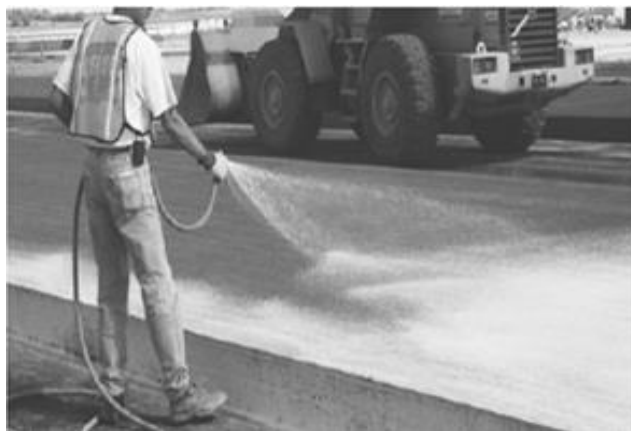
FigII.6 : Pulvérisation du Produit de Cure à la Surface du Béton.
