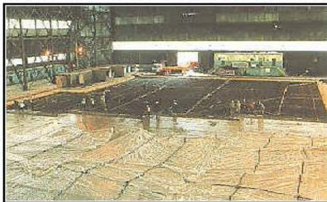
Fig. II.9 : la cure de la surface horizontale
