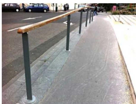
Figure 168 : Barre d'appui au bord de 2 marches Source : Guide de mobilier urbain P 56
