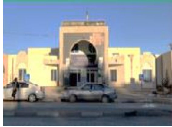
الصورة 25: محطة نقل المسافرين
