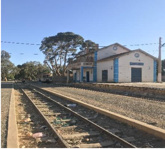
الصورة 23: محطة القطار
