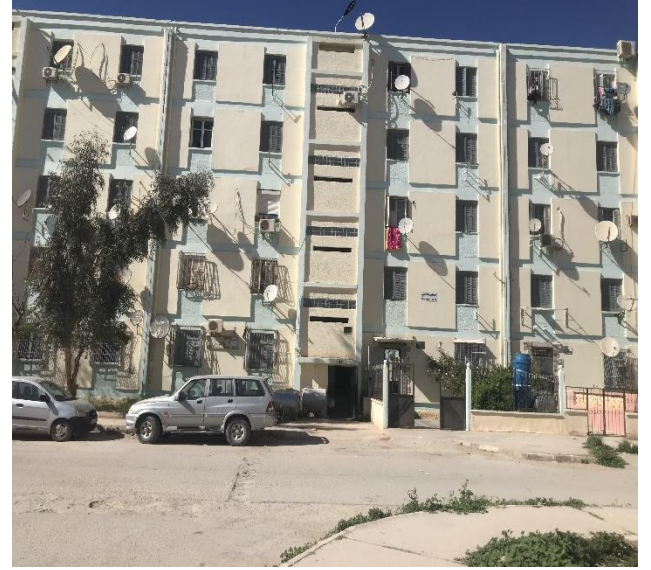
الصورة 34: واجهة العمارة قبل عملية التدخل
